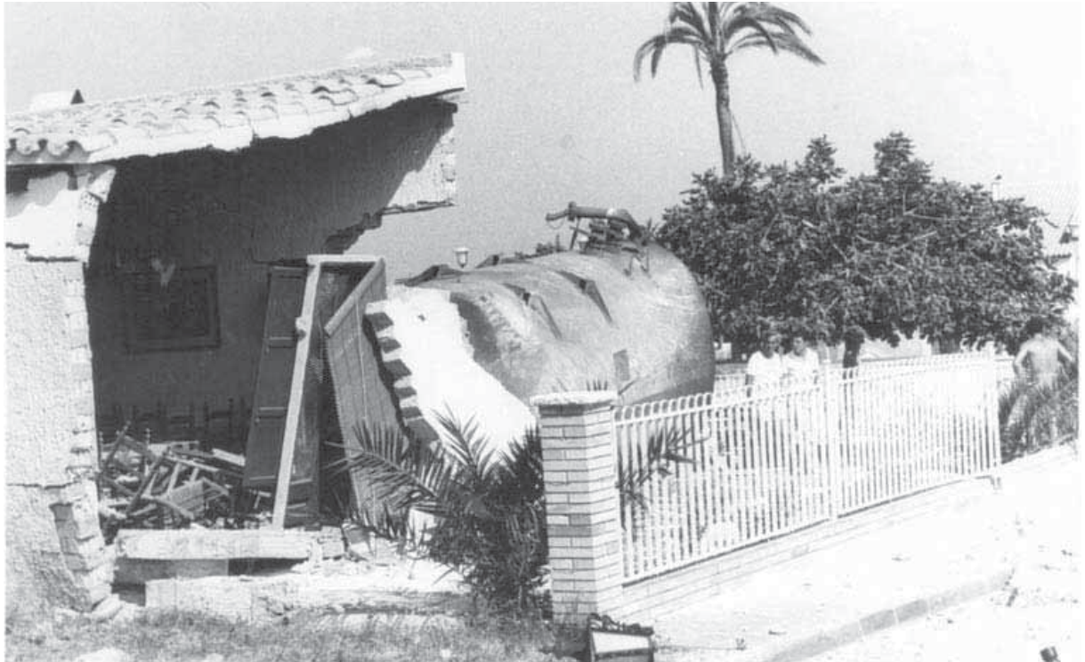
Fig. 5. "Vista 1 cisterna proyectada por explosión BLEVE"
