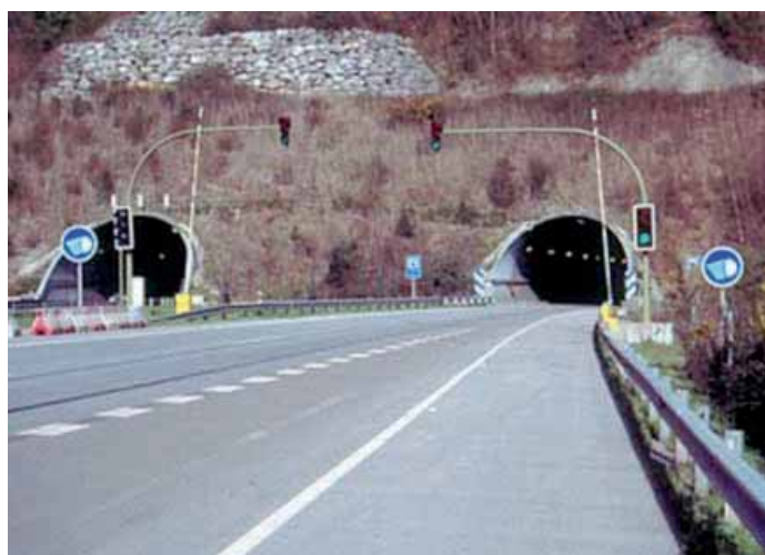
Figura 7.- Señalización de la zona de acceso en la Boca Sur de los Túneles del "Padrún", en la autovía A-66 (Asturias)
