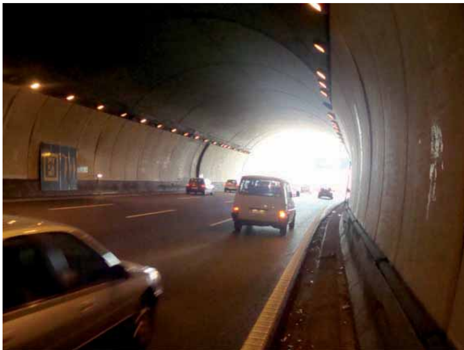
Figura 1.- Salida por la Boca Sur de los Túneles de “El Pardo”, situados en la autovía de circunvalación M-40 (Madrid)
