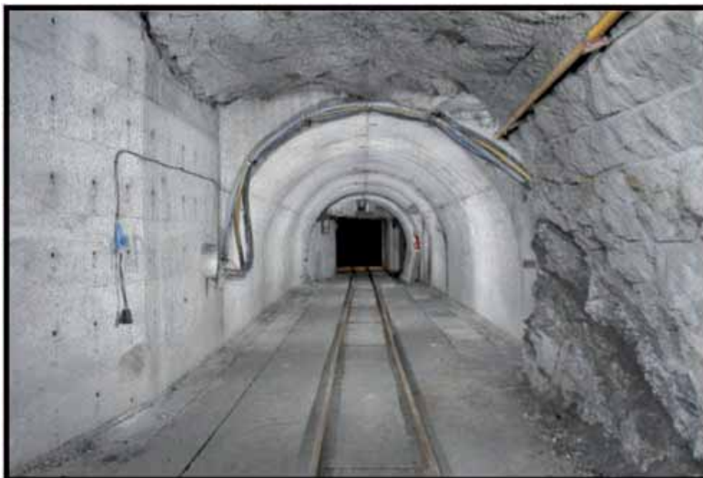
Figura 2.- Galería de incendios
