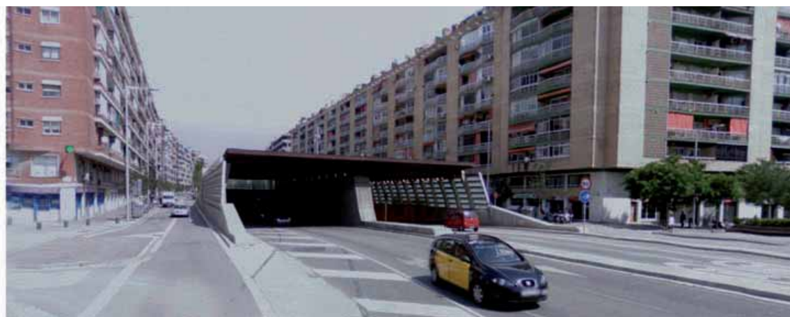
Figura 8. Boquilla de acceso al túnel de Badal. Barcelona
