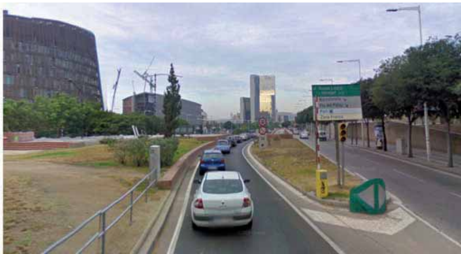
Figura 4. Control de accesos a los túneles de la Ronda Litoral. Barcelona
