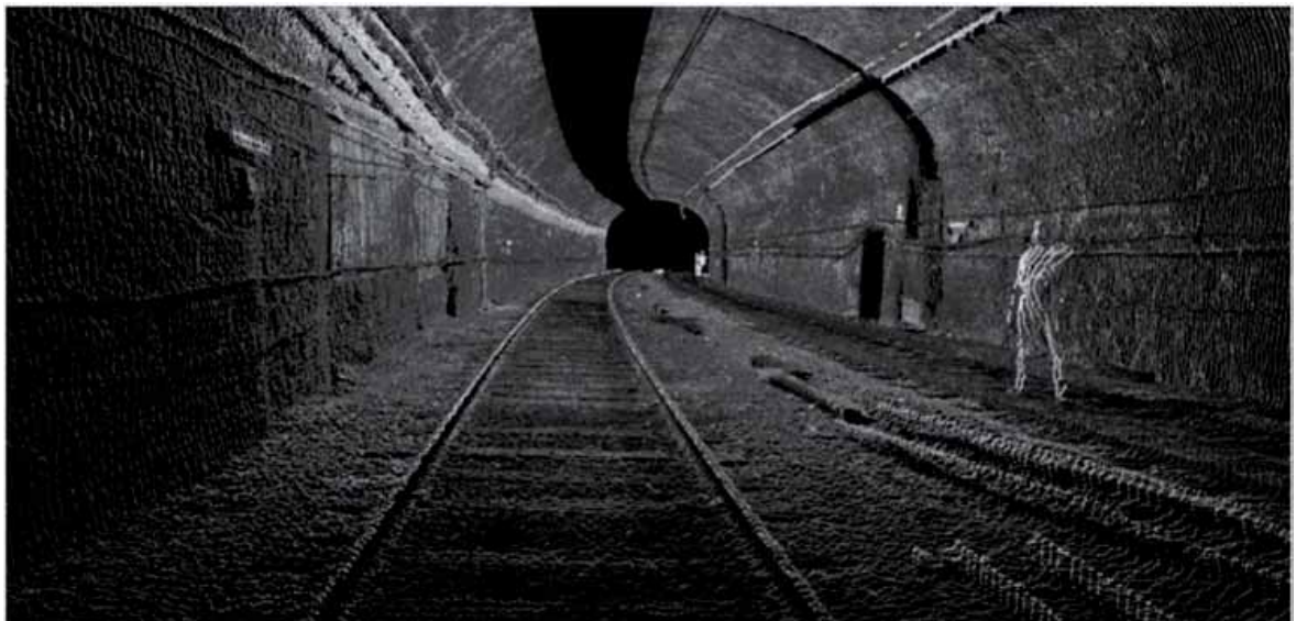
Ilustración 14: Ejemplo de una nube de puntos de un túnel de metro resultado de un levantamiento cinemático. En este caso se visualiza únicamente una nube de puntos. En un levantamiento de túneles normalmente se utilizan dos escáneres de alto rendimiento en paralelo.
