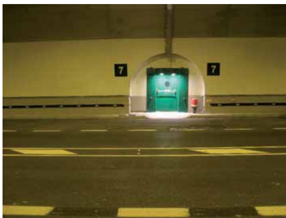
Imagen 3.- La aplicación del revestimiento termoplástico simplifica la instalación de otros elementos de seguridad reglamentarios
