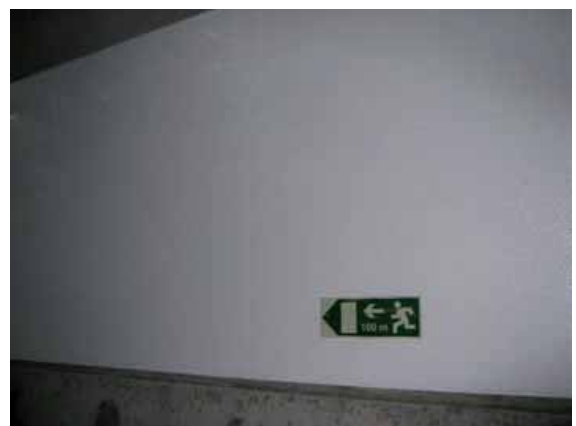
Imagen 3.- La aplicación del revestimiento termoplástico simplifica la instalación de otros elementos de seguridad reglamentarios
