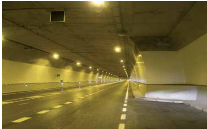
Imagen 4.- La aplicación del revestimiento termoplástico C-POX W200 HB de Barnices Valentine incide significativamente en múltiples aspectos de la seguridad y confort en los túneles de carretera.
