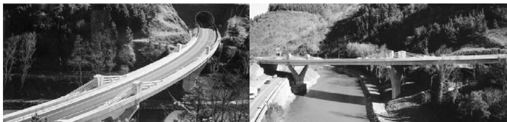
Figura 10. Puente sobre el río Deba, extradosado de Jose Antonio Ilombart.
