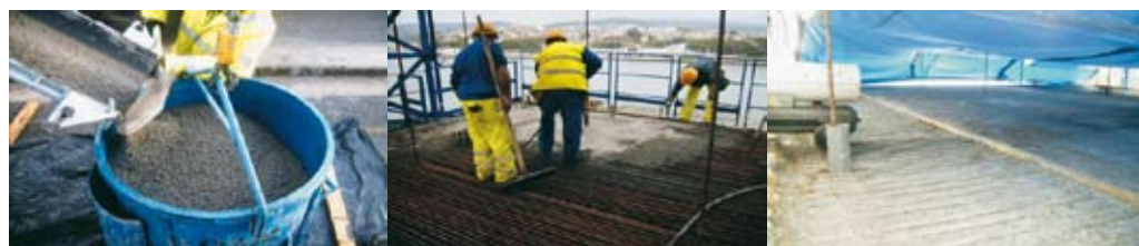
Figura 14. Losa de ampliación del viaducto de los Santos.
