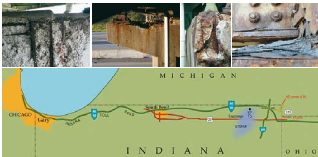
Figura 7. Reparación de los puentes de la autopista I-90, Indiana Toll Road.
