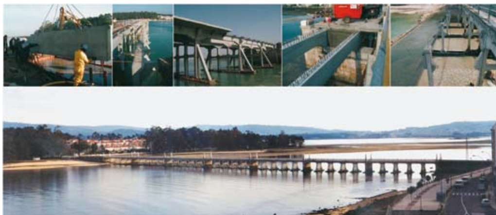
Figura 5. Inspección, diagnóstico, demolición y reconstrucción del Puente de la Toja.
