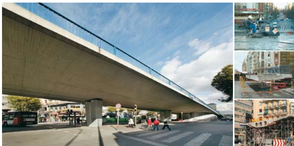
Figura 8. Demolición del paso Superior de Cuatro Caminos.
