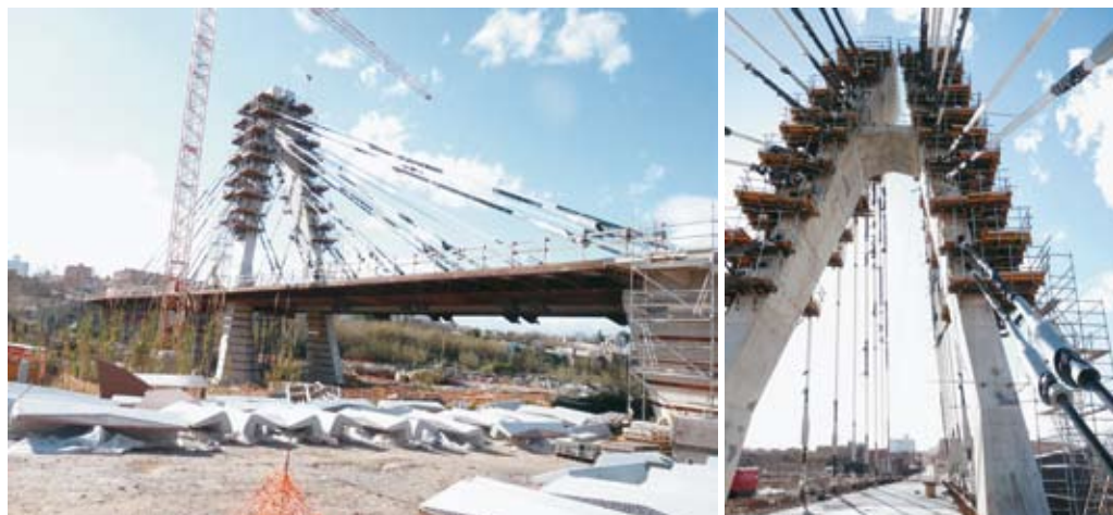
Figura 15. Puente atirantado con tablero fabricado con árido reciclado.
