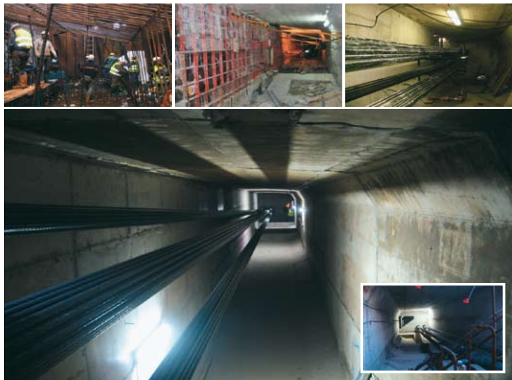
Figura 9. Refuerzo con pretensado exterior en el interior del cajón del puente de los Santos.
