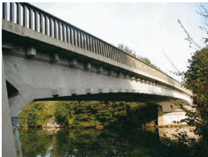
Puente de Luzancy.
