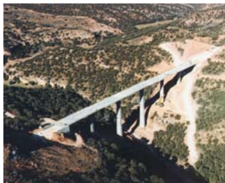
Fig. 4. Viaducto 4. Arcos de Jalón (Soria).
