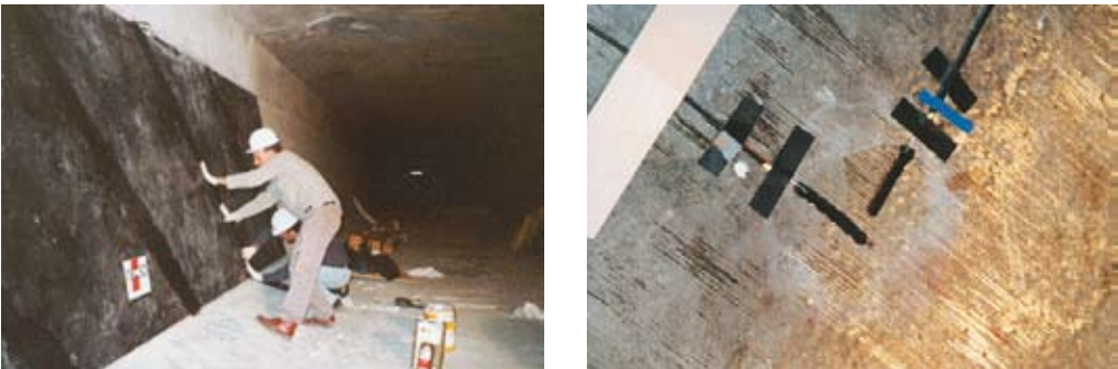
Fig. 6. Proceso de instalación del refuerzo y monitorización en el interior de la dovela.
