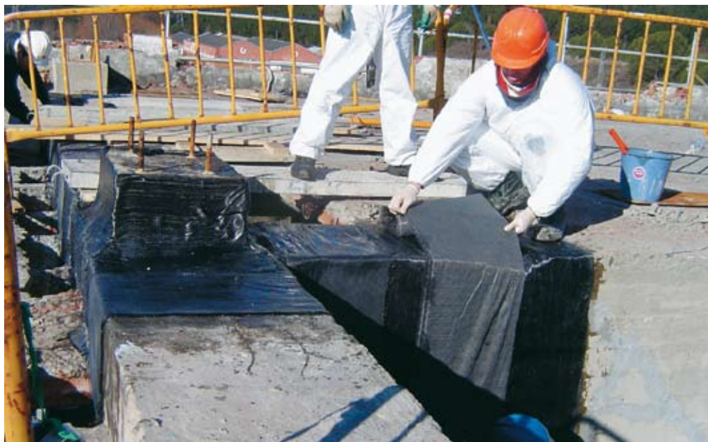
Fig. 2. Refuerzo de estructura con fibra de carbono.
