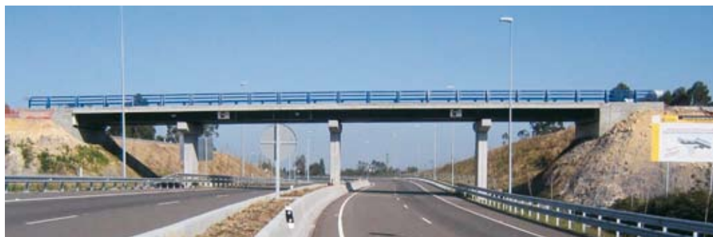
Fig. 7. Puente en materiales compuestos en la Autovía del Cantábrico.
