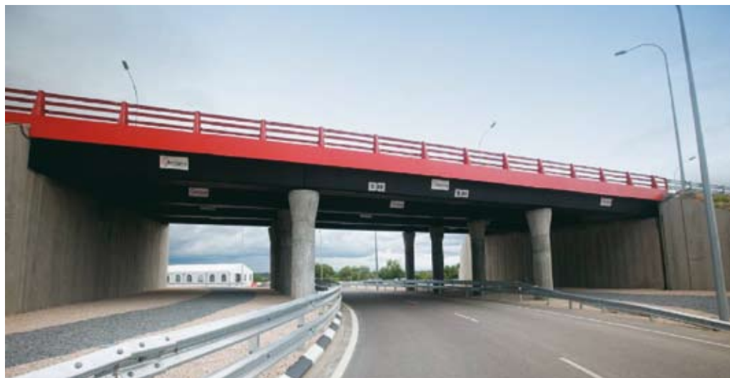
Fig. 9. Puente en materiales compuestos en la M-111 (Madrid).
