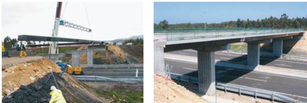
Fig. 8. Puente en la Autovía del Cantábrico. Proceso constructivo.
