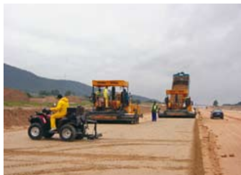
Figura 9. Prefisuración con quad.
