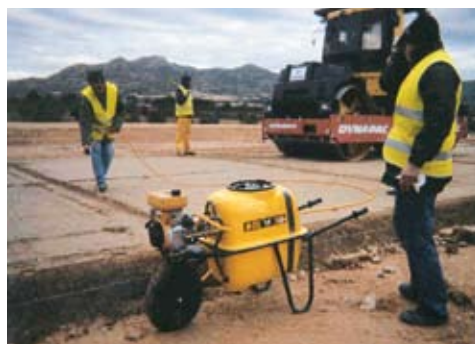
Figuras 4 y 5. Prefisuración con placa vibrante e introducción manual de la emulsión.
