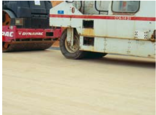
Tren de compactación, en cabeza el metálico.
