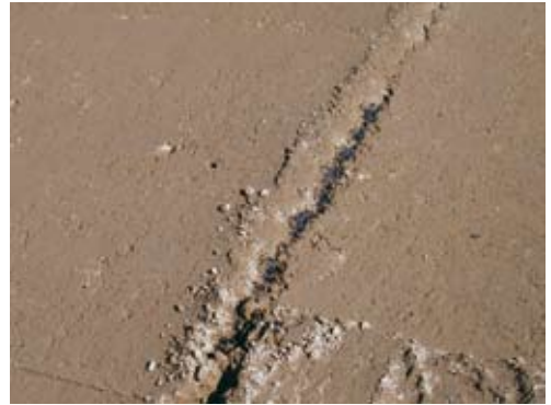
Durante la compactación.
