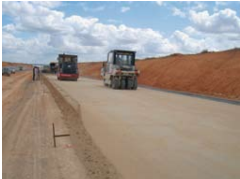
Tren de compactación, en cabeza el metálico.
