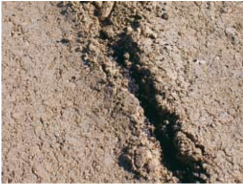
Vista antes de compactación.
