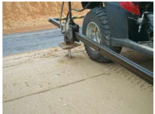
Ejecución del prefisurado, existe un ancho de 25 cm, que se ve que no se prefisura.
