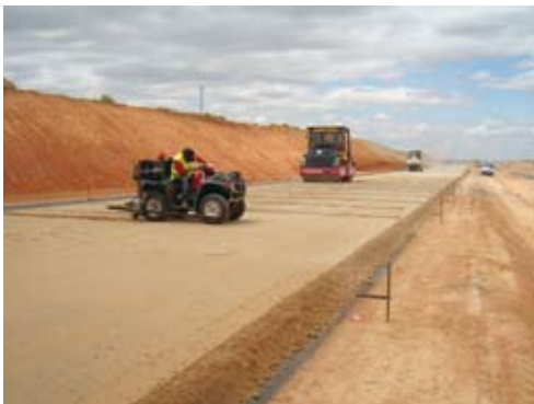
Vista del tren de compactación.
