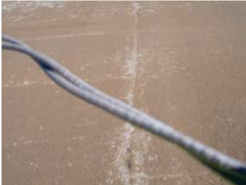
Durante la compactación.
