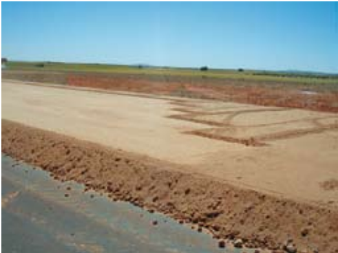
Terminación del rodillo metálico.
