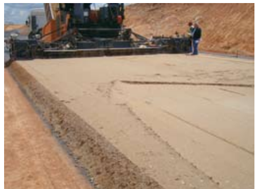
Terminación del rodillo metálico, en margen izquierda.
