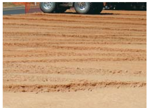
Aspecto del material antes de entrar el rodillo metálico.
