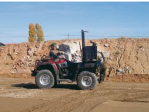
Equipo para ejecución de juntas.
