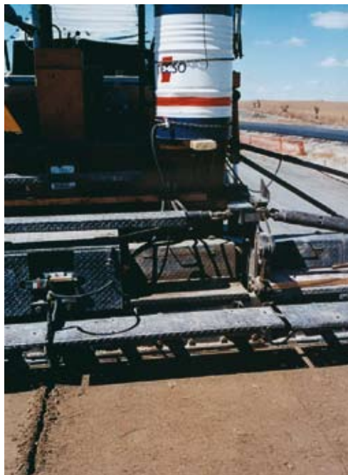
Foto 6. Prefisuración longitudinal.
