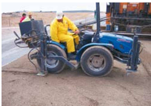
Foto 3. Prefisuración con equipo móvil.
