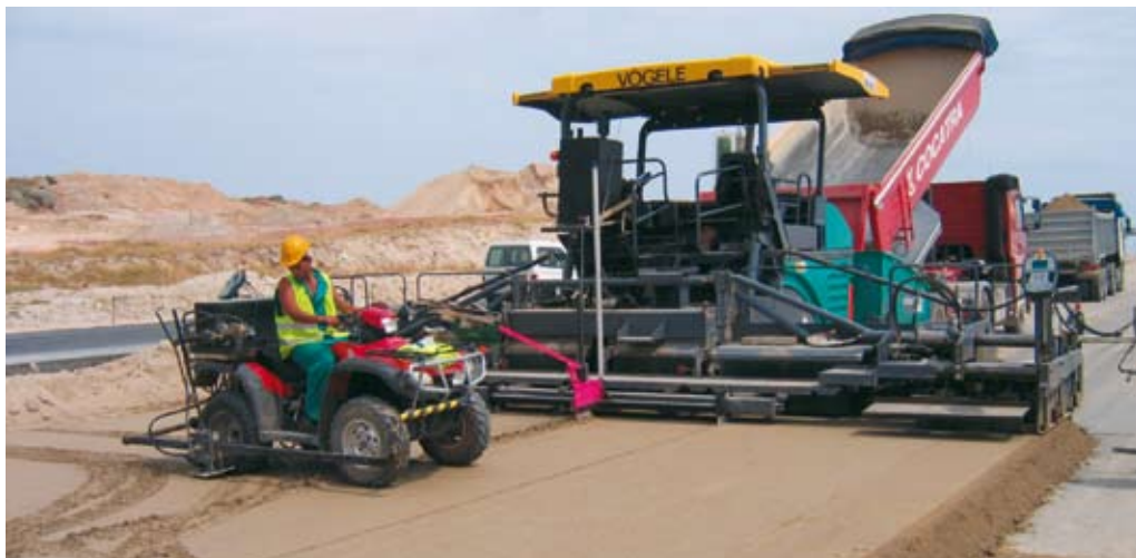
Foto 2. Prefisuración en fresco.
