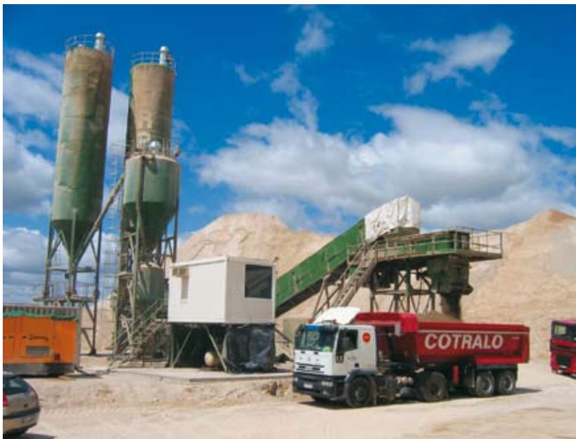
Foto 1. Planta de suelocemento.
