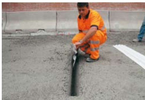
Fase 2: Inserción de la junta en el hueco.
