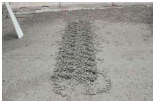
Junta terminada preparada para compactación.
