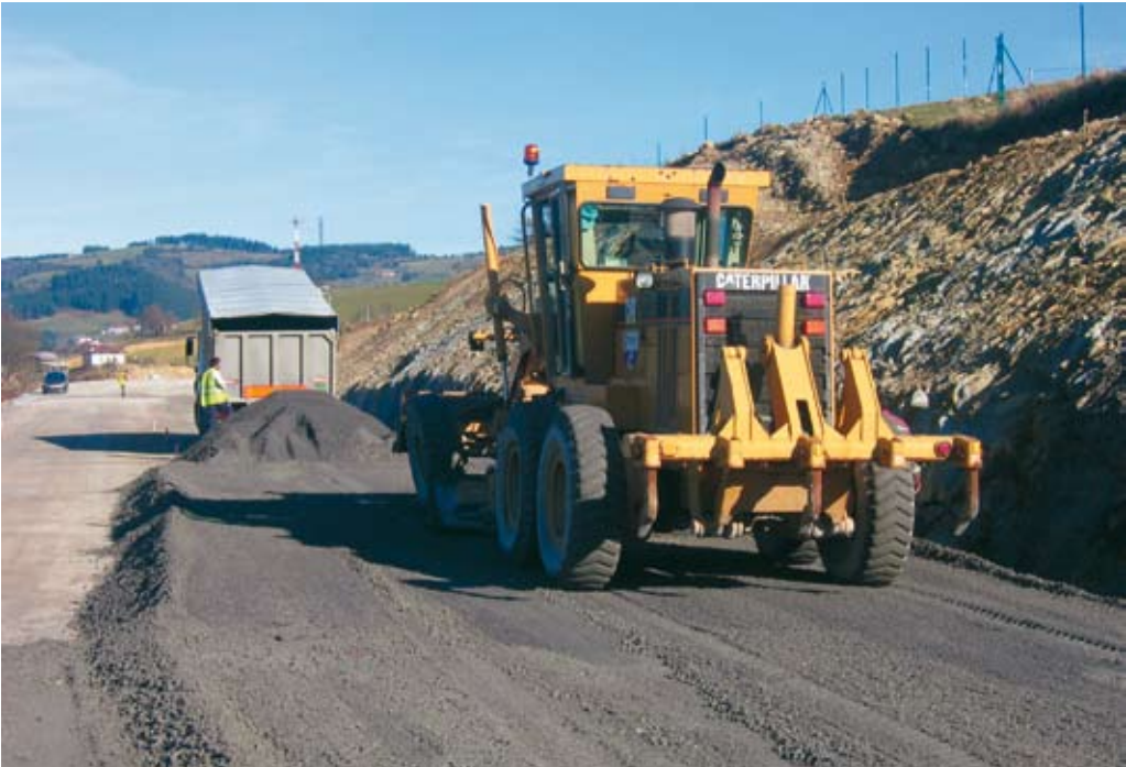
Extendido con motoniveladora. Variante de Larrabetzu (2004).
