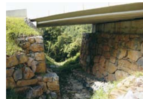
Parte Noroeste del paso. FOTO: J. FORCADA
