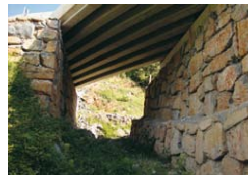
Parte Sureste del paso. FOTO: J. FORCADA
