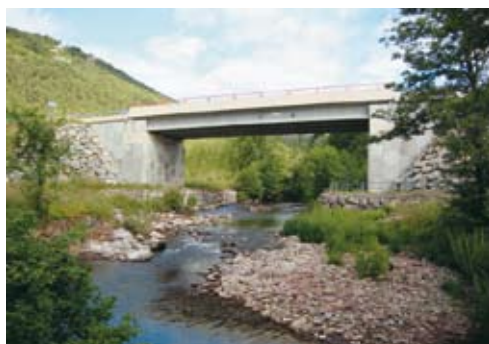
Puente aguas abajo del paso. FOTO: J. FORCADA
