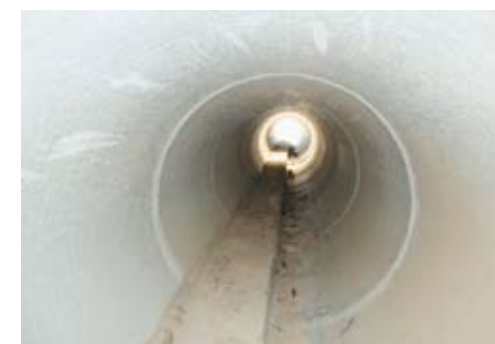
Interior y luz de la chimenea central. FOTO: J. FORCADA
