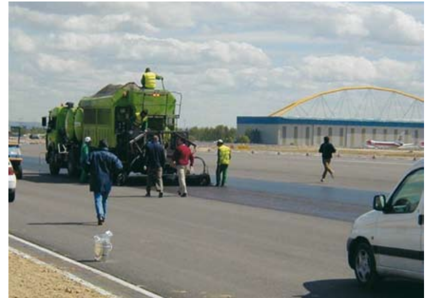
Cuando se puede trabajar de día (en aeropuertos con varias pistas) se elevan los rendimientos.
