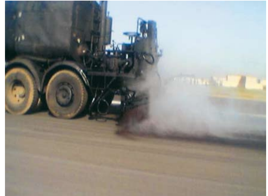
Detalle de la rampa de la cisterna para aplicar el riego de adherencia.
