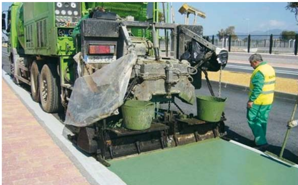
Otra forma de señalizar carriles de ciclistas o peatones es la aplicación de lechadas con ligantes sintéticos. La aplicación con máquina permite altos rendimientos. El mezclador y las rastras no precisan paletas.
