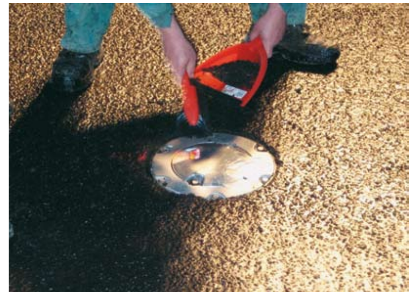
Hay que hacer una limpieza a conciencia. Antes de abrir la pista se recorre entera para evitar que por olvidos se encuentre el tráfico con elementos de las obras (alicates, atornilladores, áridos gruesos, cables, palas, rastras, carretillas, etc).
