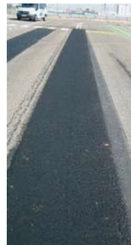
Hay aplicaciones que requieren lechadas muy fluidas para aplicaciones de relleno de grietas. LB-4 en aeropuertos.
