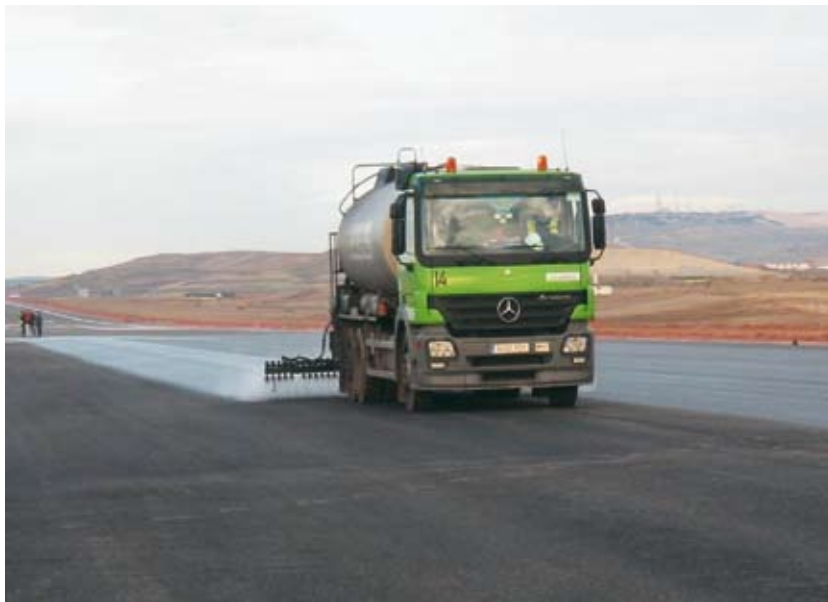
Ningún riesgo de despegue de capas. Riego de adherencia antes de la aplicación.
