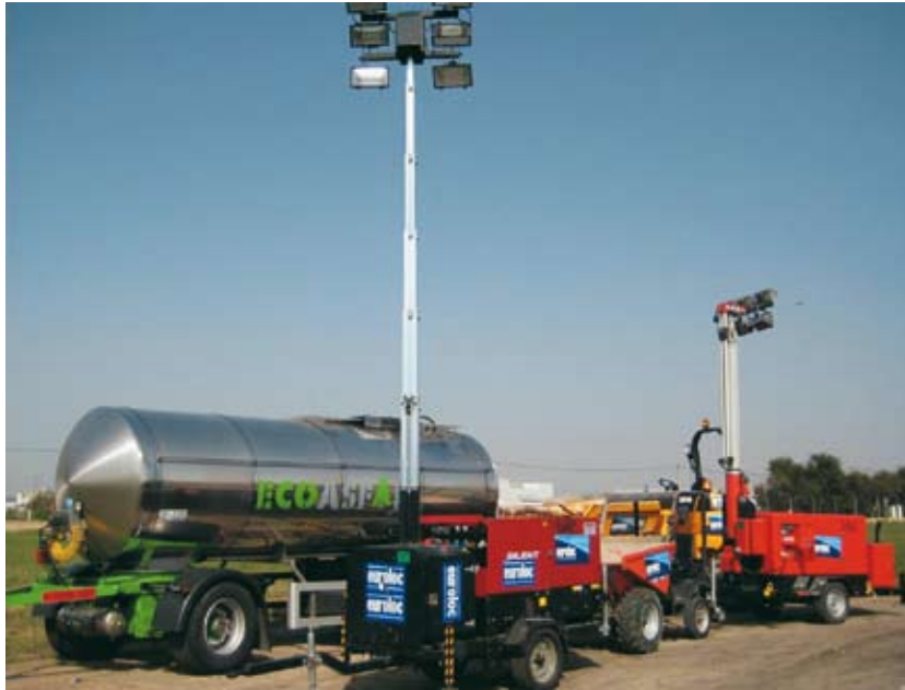
Equipos para trabajos nocturnos.
