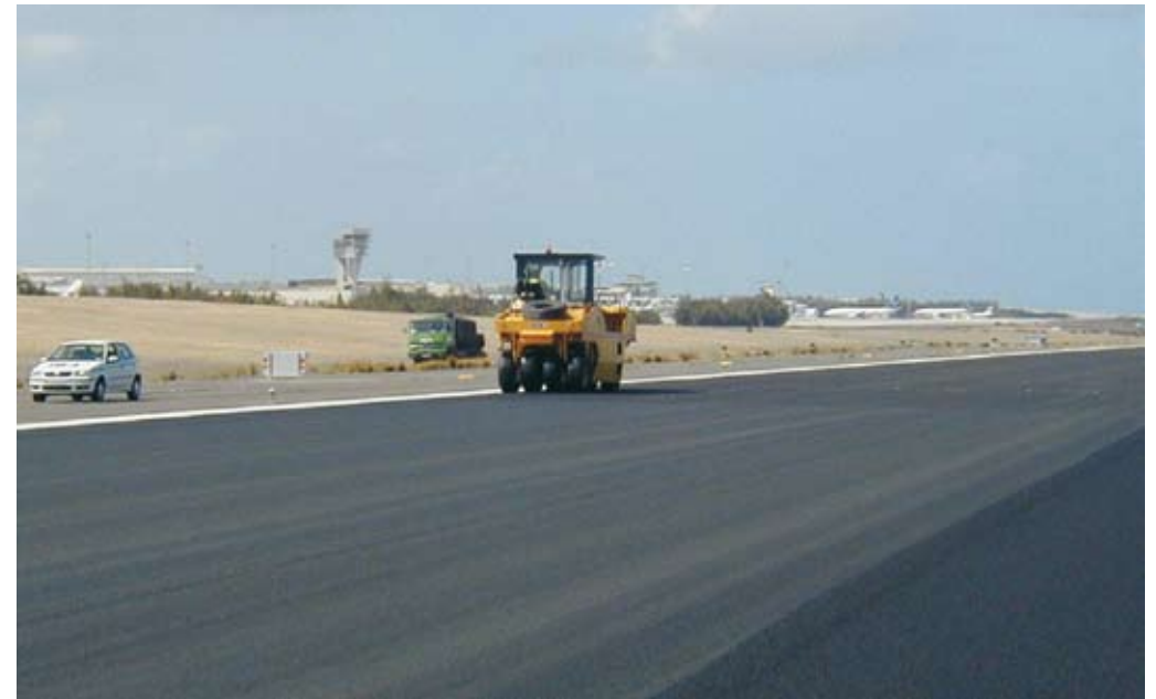
En la compactación se acelera el curado terminándose de evacuar el agua de la Lechada Bituminosa.
