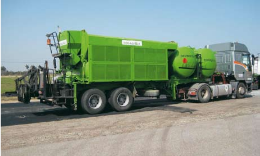
La máquina de aplicación de la Lechada:
