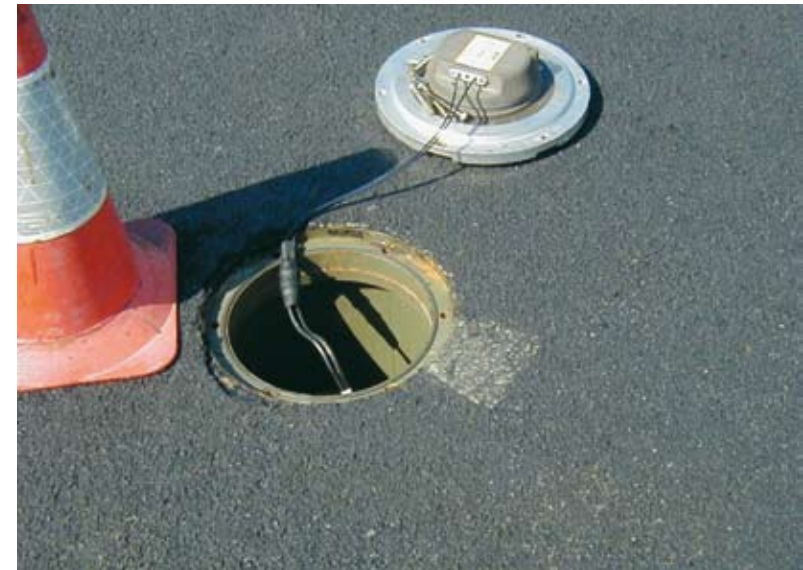
Una vez aplicado el tratamiento se colocan las luces.
