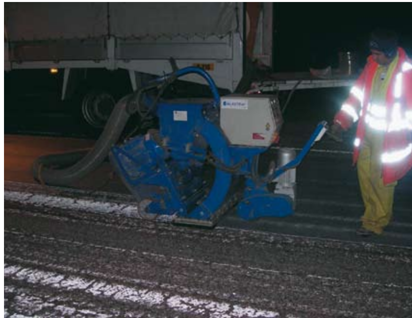
La granalladora quitando las sábanas de pintura en horario nocturno. Estas operaciones se hacen mientras se preparan los equipos para hacer el tratamiento con Lechadas.
