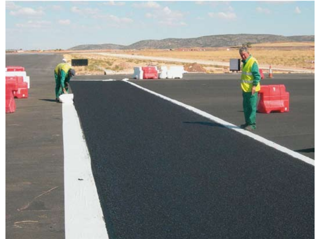
Retirada de cinta adhesiva en zonas tratadas. Perfilado del trabajo realizado. Los hombres con su experiencia son determinantes en las actuaciones tan rigurosas como la que se hacen en aeropuertos.
