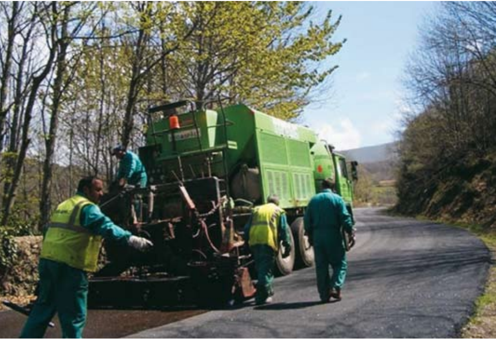
En carreteras de montaña, lechadas bituminosas con filleres antihielo. Un 4 a 5 % de Gricol que se adiciona en los áridos. Funciona como si ya hubiésemos puesto sal en la carretera tras la nevada y si se forma hielo, tiene menor adherencia al pavimento.
