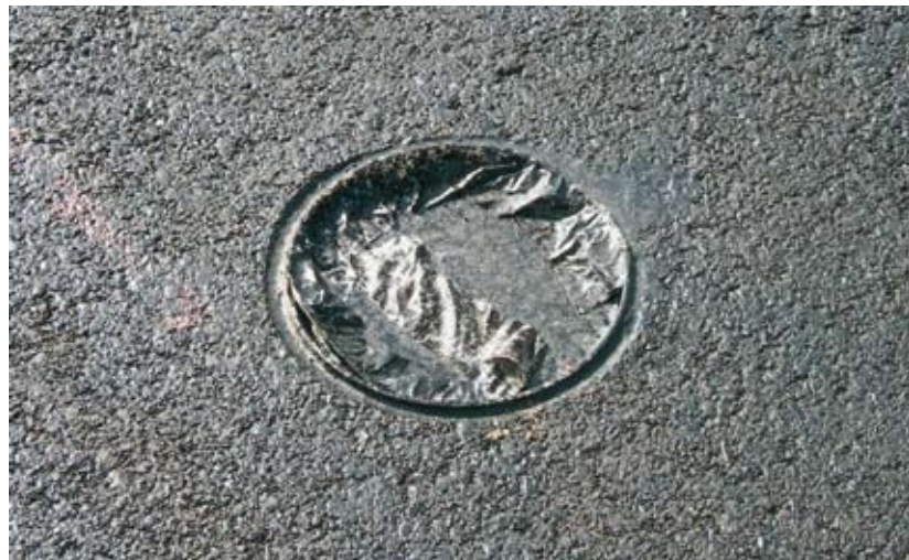
La protección de las luces aeronáuticas durante la aplicación de Lechadas Bituminosas, en las pistas de los aeropuertos, permite un ahorro considerable al no tener que elevarlas por el tratamiento (de tan bajo espesor). El levantamiento de balizas cuesta tanto o más que el tratamiento.
