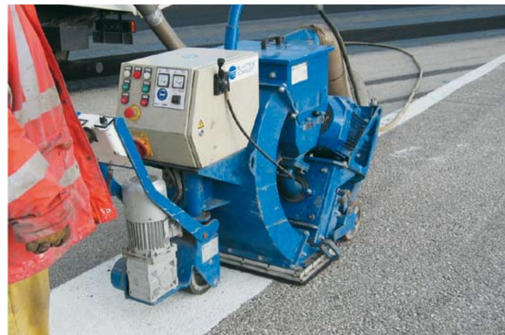
Limpieza del soporte antes de la aplicación de la Lechada Bituminosa. Limpieza de caucho, de pintura o ambos. Generalmente, en aeropuertos se hace un riego de adherencia para asegurar el pegado de la capa al soporte y que en las operaciones de las aeronaves no se produzcan problemas de adherencia de la lechada al soporte. Si no se quita la pintura no hay buena adherencia.
