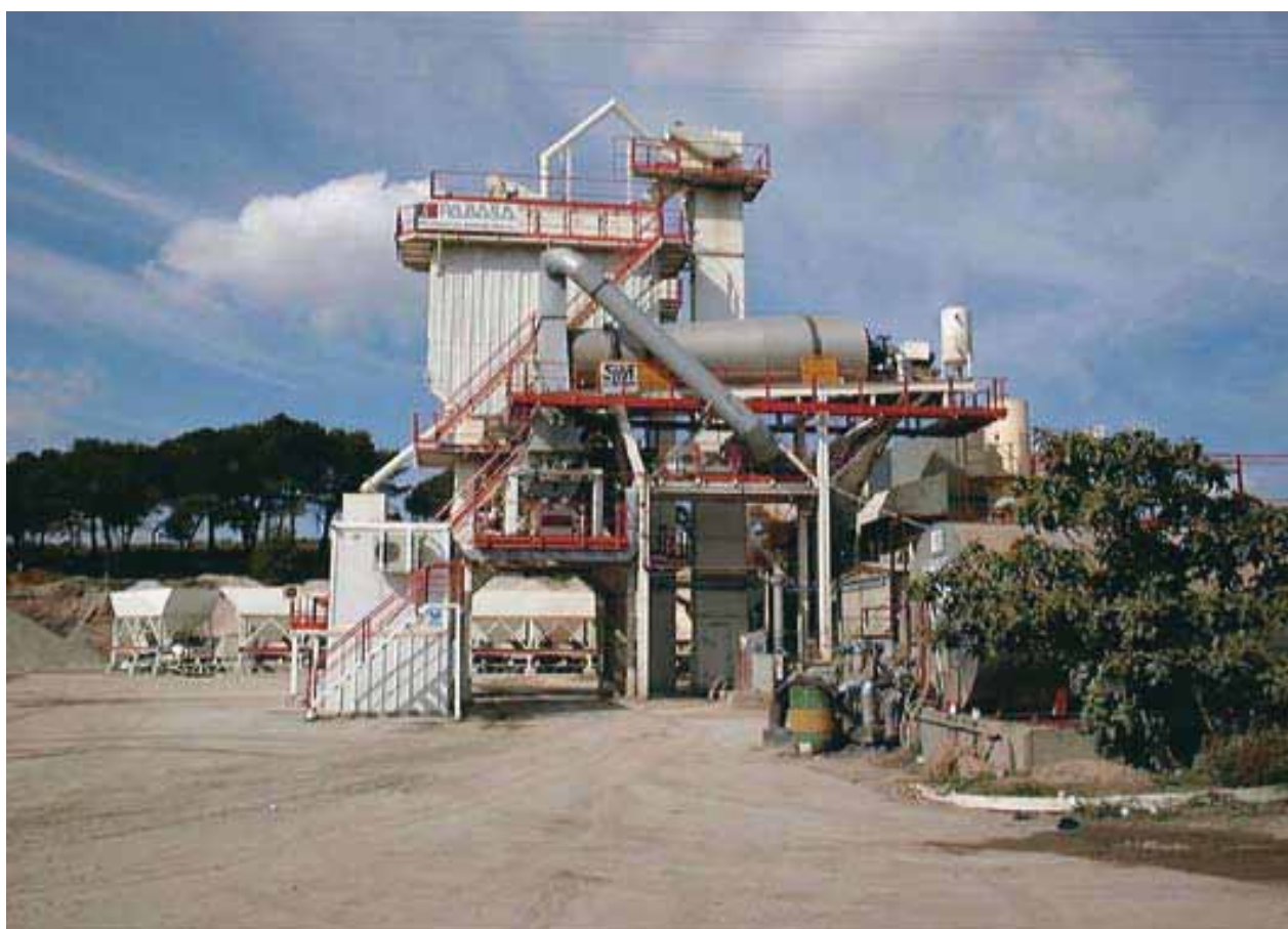
1. Instalación asfáltica equipada para fabricar reciclado en altas tasas.
