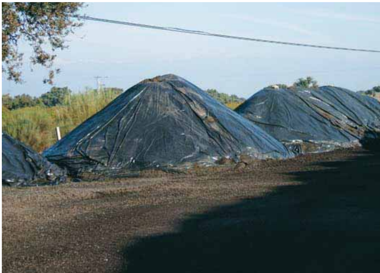
6. Acopios de fresado cubiertos. Obra: Reparación y refuerzo del firme. Carretera A-5. Autovía del Suroeste. LP con Toledo – Almaraz.
