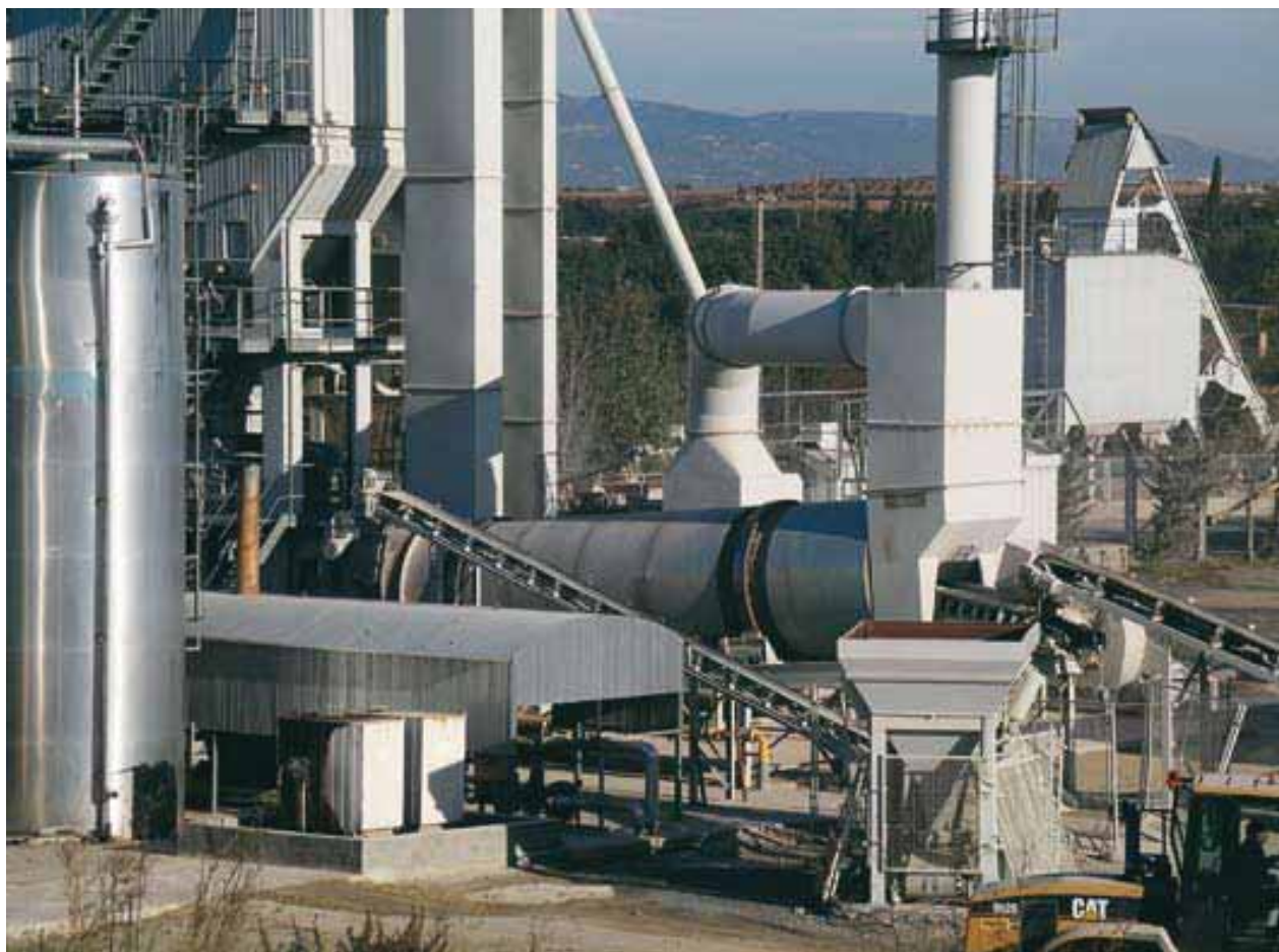
3. Incorporación del fresado en el conducto de descarga del tambor secador.
