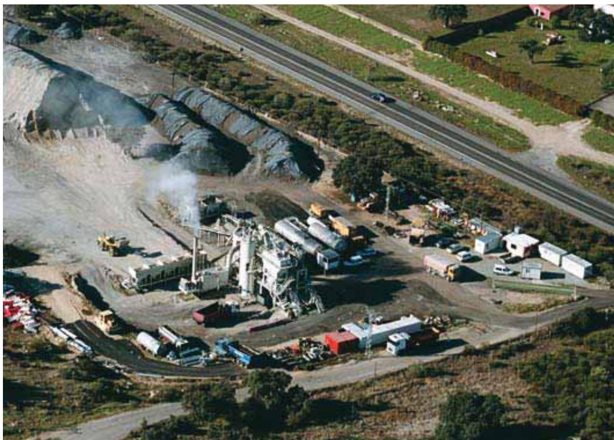
7. Fotografía aérea de la Planta Asfáltica instalada en la obra para la reparación y el refuerzo del firme de la Carretera A-5. Autovía del Suroeste. LP con Toledo – Almaraz.
