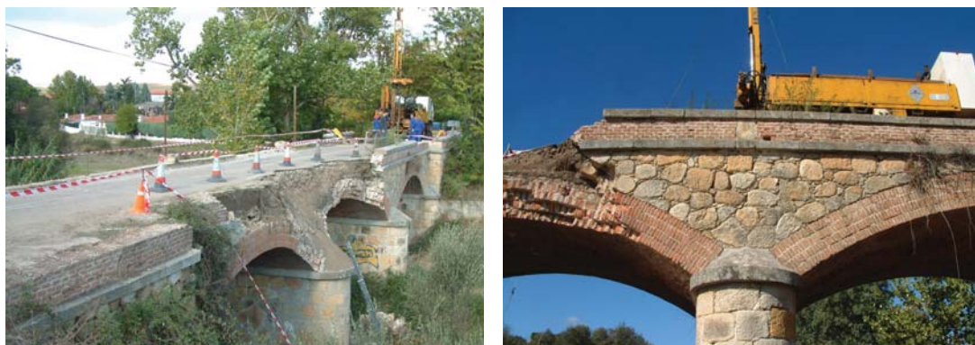
Figura 3.6. Ejecución de sondeos en un puente.
