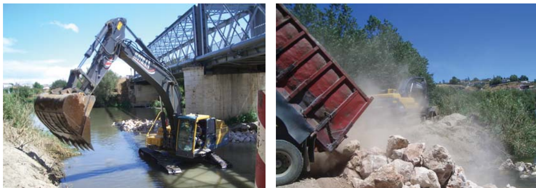
Figura 3.11. Ejecución de plataforma de trabajo para el recalce de las pilas de sillería del puente metálico de Titulcia.
