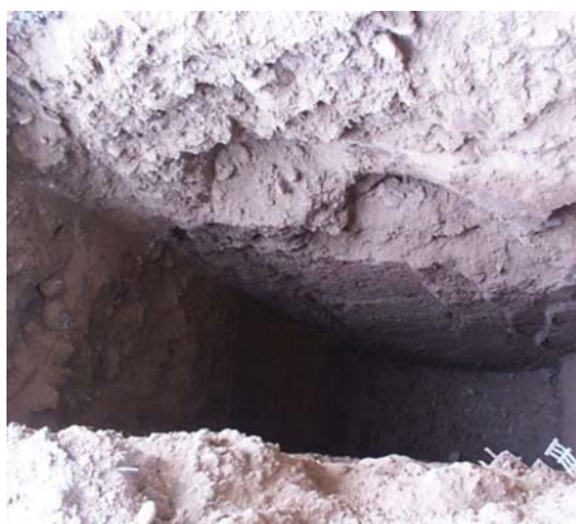
Figura 3.5. Detalle de cata en un puente.
