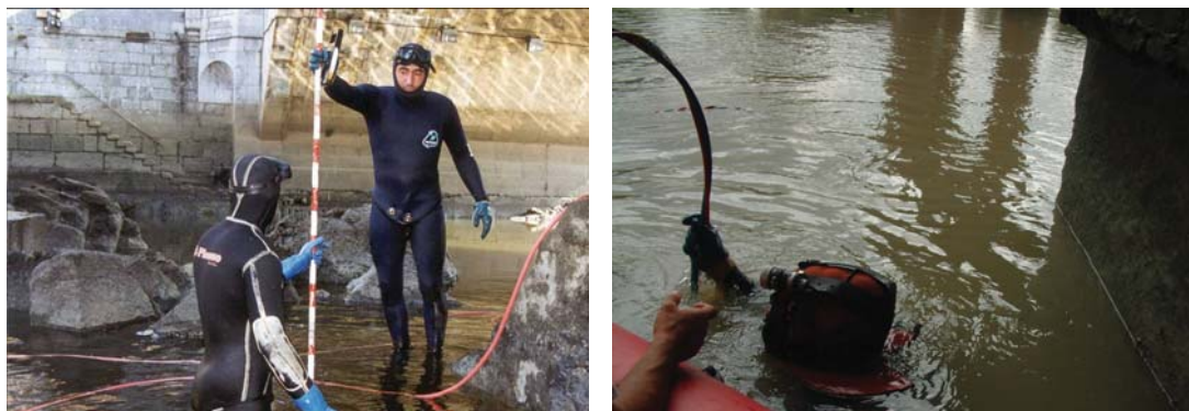
Figura 3.8. Trabajos de inspección subacuática.
