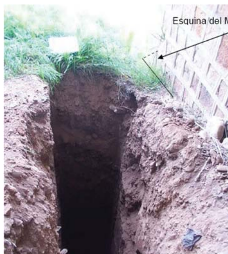
Figura 3.4. Ejecución de cata en un puente.
