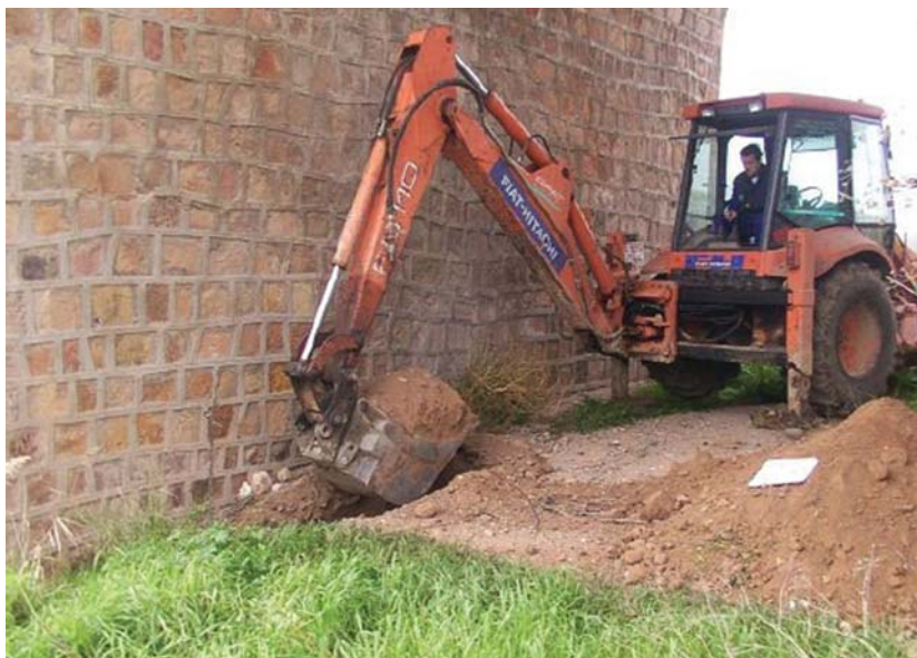
Figura 3.4. Ejecución de cata en un puente.
