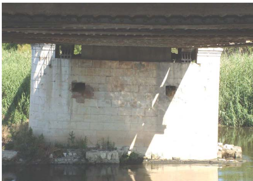
Figura 3.1. Giro y descenso de una pila (apréciese la inclinación con respecto a la lámina de agua).
