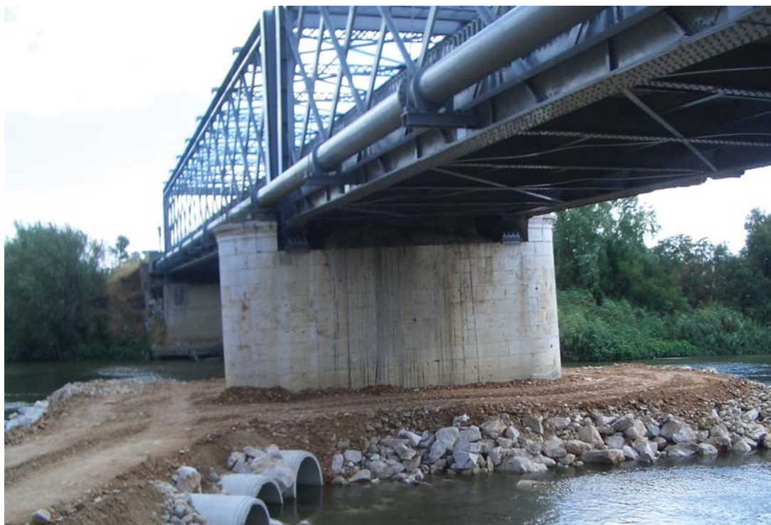
Figura 3.12. Plataforma de trabajo para el recalce de las pilas de sillería del puente metálico de Titulcia.
