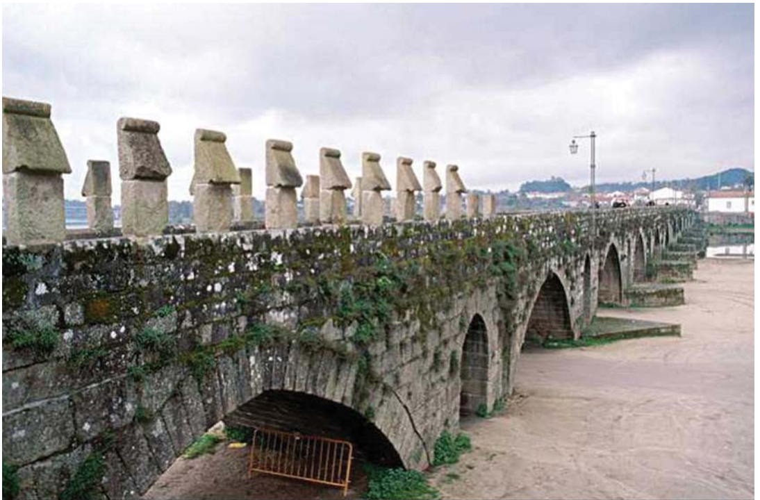
Figura 4.14. Puente romano en Ponte de Lima (Portugal) sobre el río Lima.
