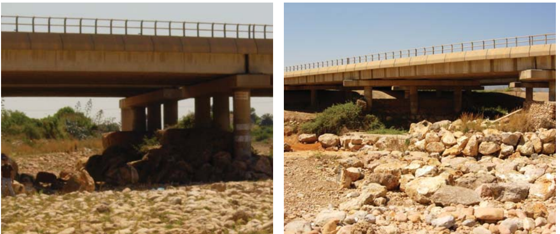
Figura 4.24. Protección situada sobre la cota del lecho en avenidas. Vista desde aguas arriba (izquierda) y lateral (derecha).
