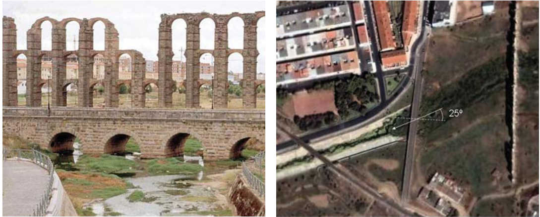
Figura 4.4. Puente romano sobre el río Albarregas (Mérida). Obsérvese tanto en alzado (izquierda) como en planta (derecha), el apreciable esviaje ( 25^\circ ) entre los ejes de las secciones hidráulicas geométrica y efectiva.
