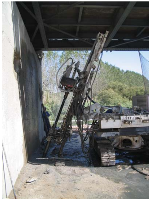
Figura 6.2. Perforación en una pila de sillería por debajo del tablero, con un carro perforador apto para trabajar en espacios de gálibo reducido.
