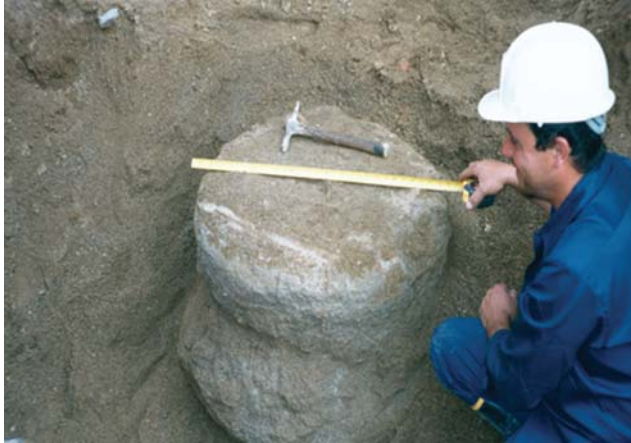
Figura 6.11. Excavación e inspección visual con toma de medidas de columna.
