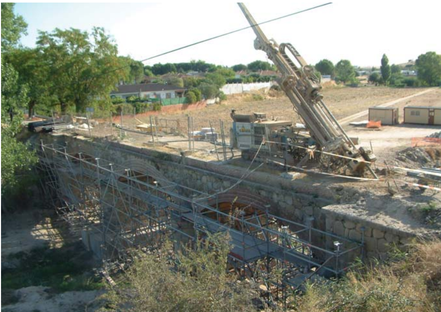
Figura 6.4. Ejecución de micropilotes inclinados en un estribo de un puente de fábrica desde la plataforma del puente.
