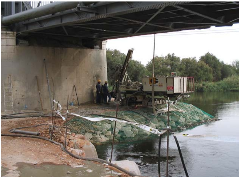
Figura 6.7. Maquinaria de ejecución de columnas de jet grouting.
