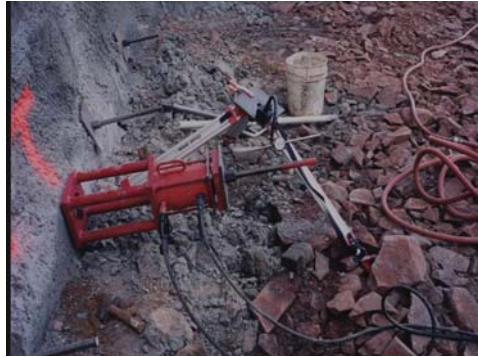
Figura 6.22. Ensayo de arrancamiento de un bulón.
