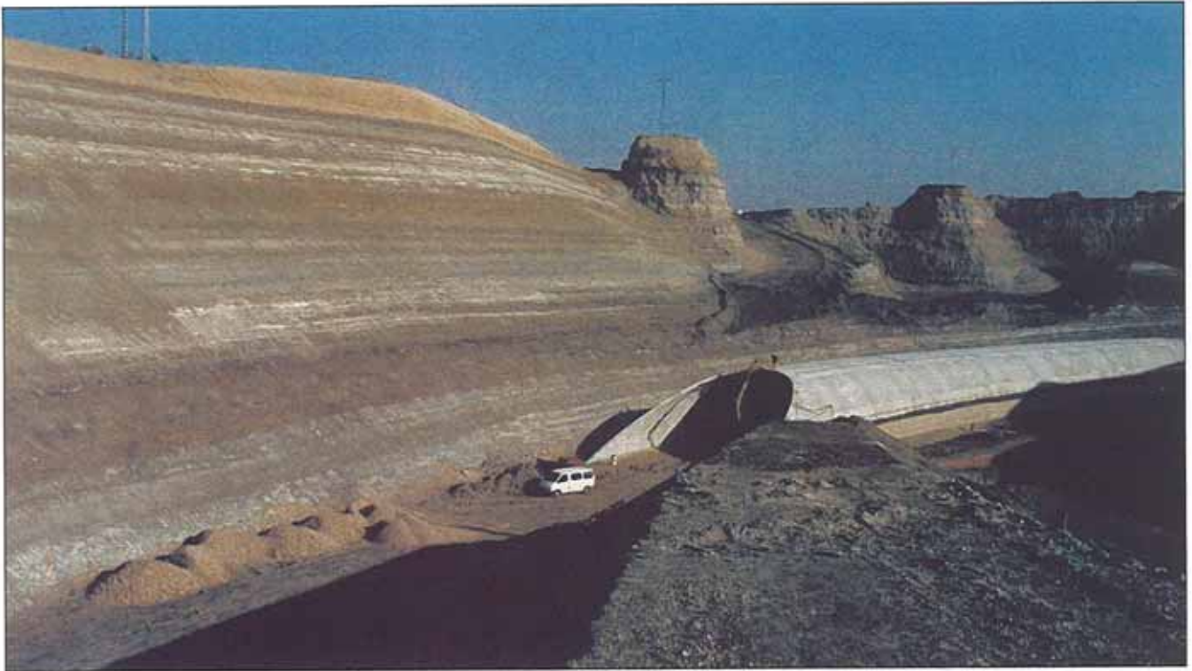
Fase de las obras en la que se aprecia la gran depresión realizada en los ramales de conexión con la N-II.
