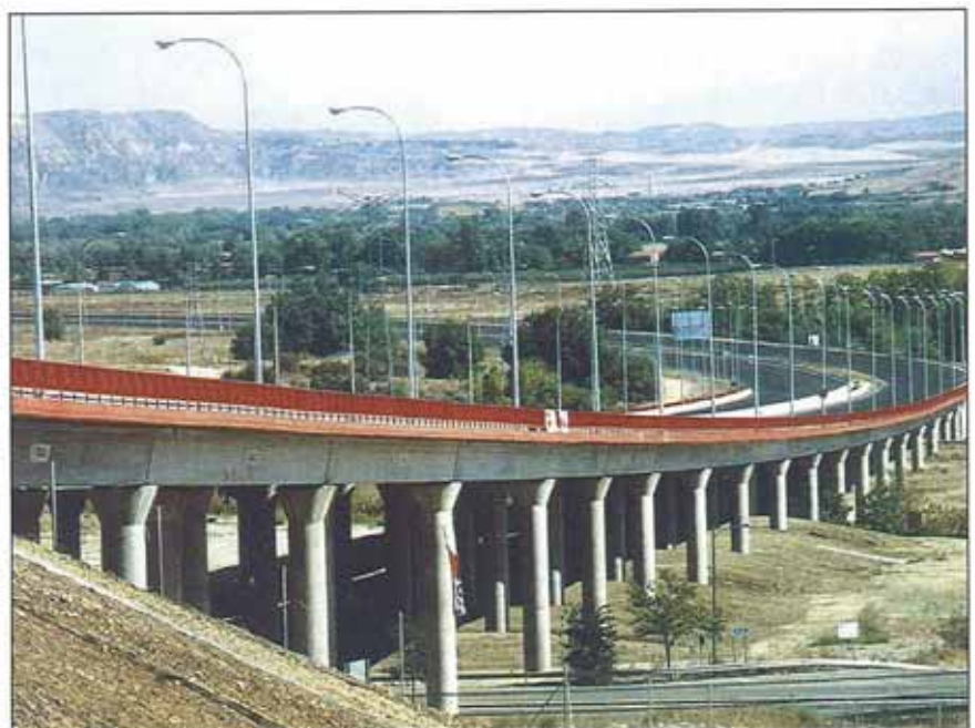
La obra cuenta con 17 estructuras.
