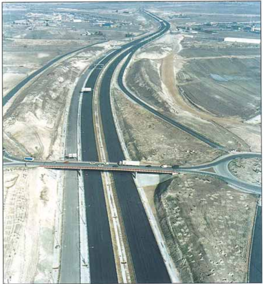
El diseño de la nueva autopista abre la posibilidad a una futura ampliación a 4 carriles por sentido de la circulación.
