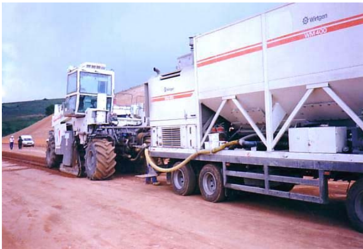
figura 3: Ejecución de estabilización por vía húmeda con equipos continuos (fuente SOLTEC)
