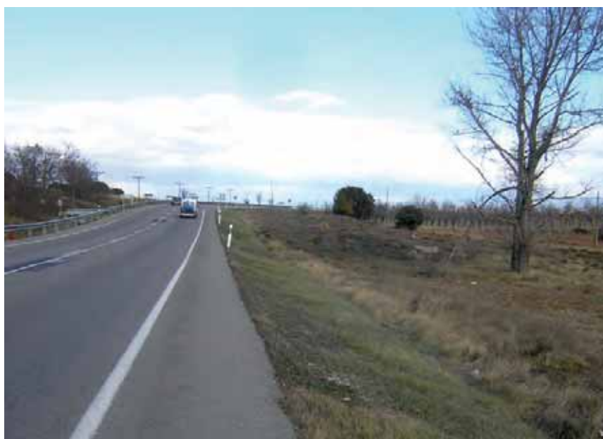
Figura 3. Indicador de inclinación de márgenes = 4: Inclinación vertical de 1:3 con desnivel de altura superior a 1 m.
