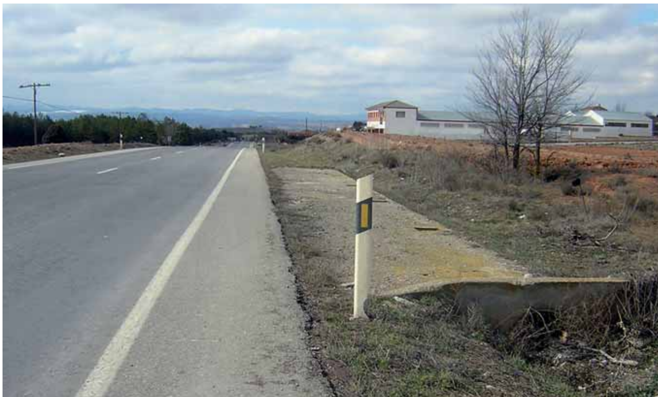
Figura 5. Indicador de obstáculos = 4: Obstáculos localizados a menos de 3 m del borde de la calzada.
