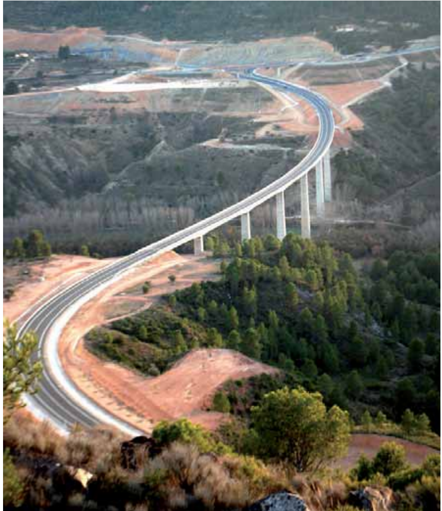
Vista aérea del viaducto sobre el río Cabriel, de 521 m de longitud y 50 m de altura sobre el valle.
