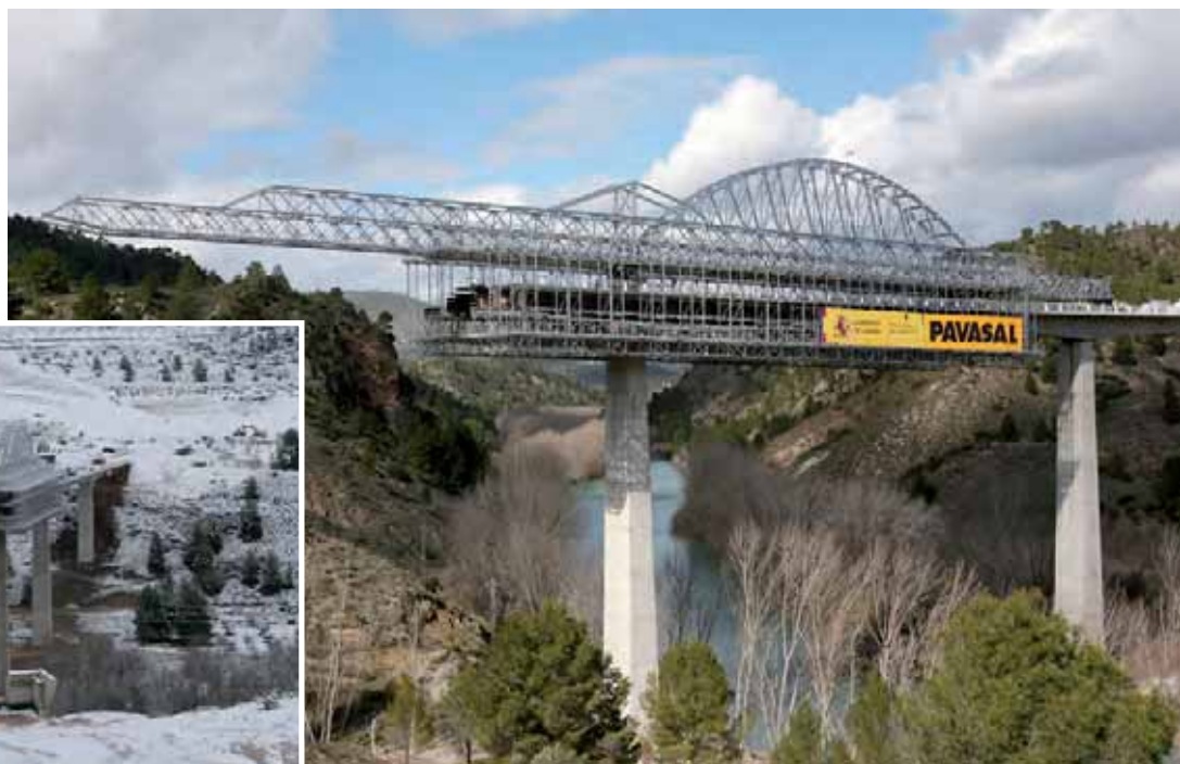
Vistas de la construcción de una cimbra en diferentes periodos.
