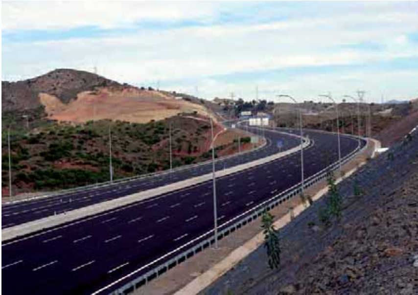
En la imagen se aprecian los 4 carriles por sentido de la circulación del nuevo tramo.
