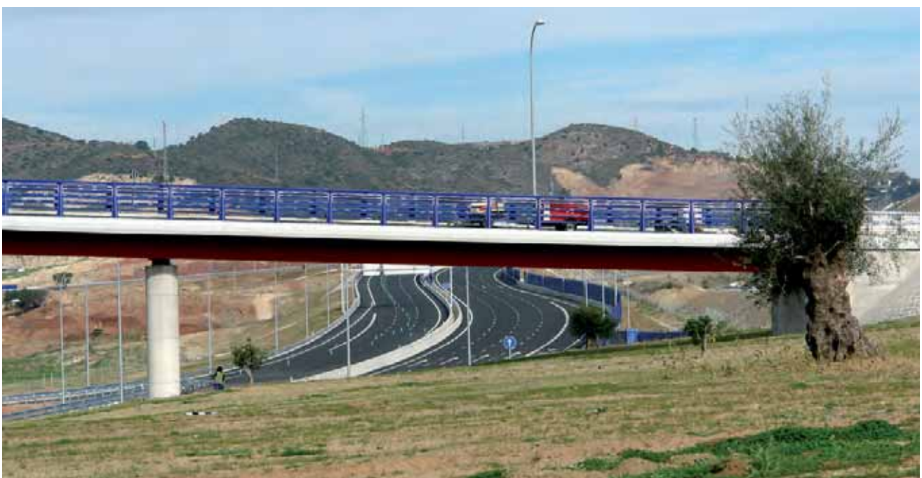
Enlace Nueva Ronda de Málaga - (A-357).
