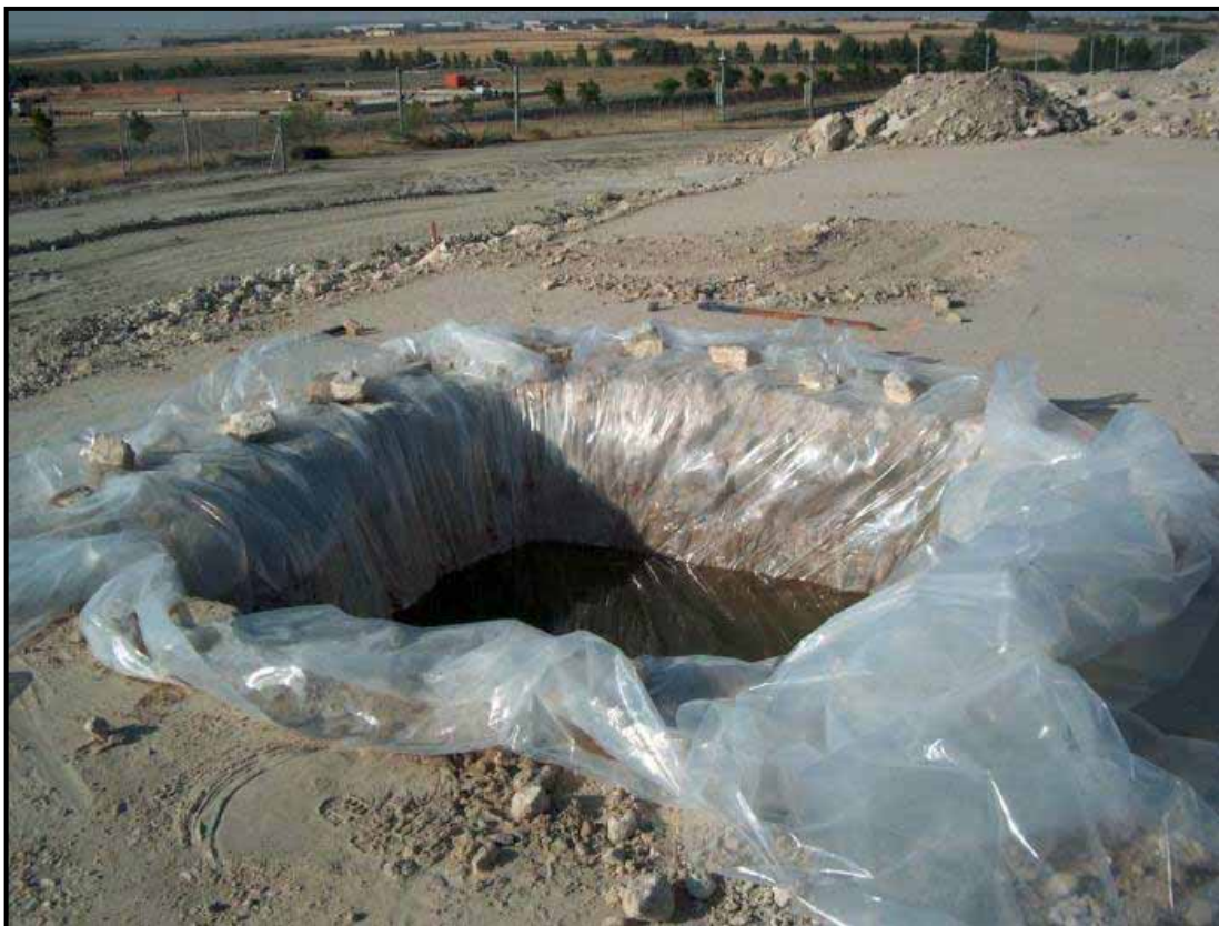
Fig. 15.- Aspecto general de un terraplén de yesos en R-4
