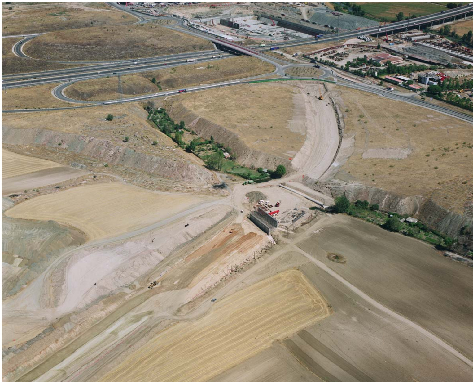
figura 10: Vista general de la ejecución de la excavación del desmonte en el vertedero y comienzo de los trabajos de compactación dinámica
