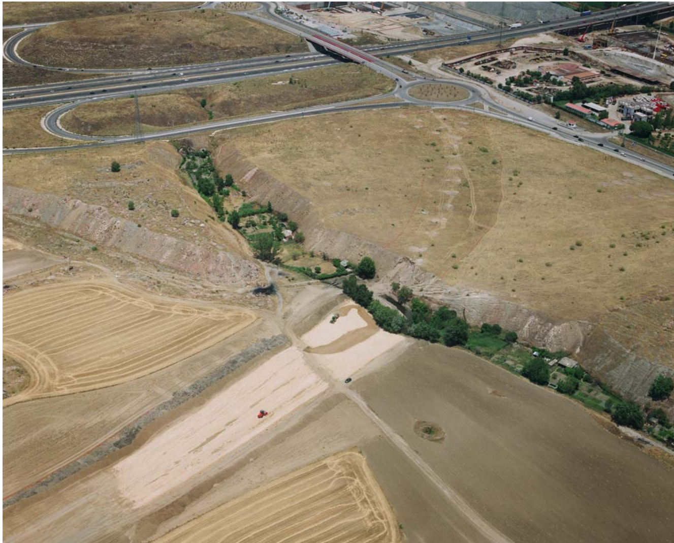
figura 3: Vista general del vertedero de San Martín de Valdeiglesias antes del comienzo de las obras
