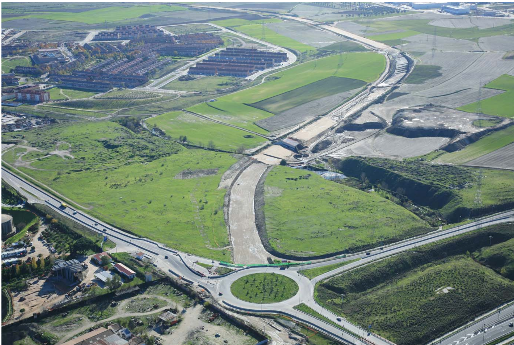
figura 15: Vista general del tramo afectado por el vertedero tras la compactación dinámica
