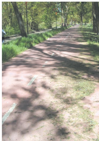
Foto 13. Limpieza y mantenimiento
