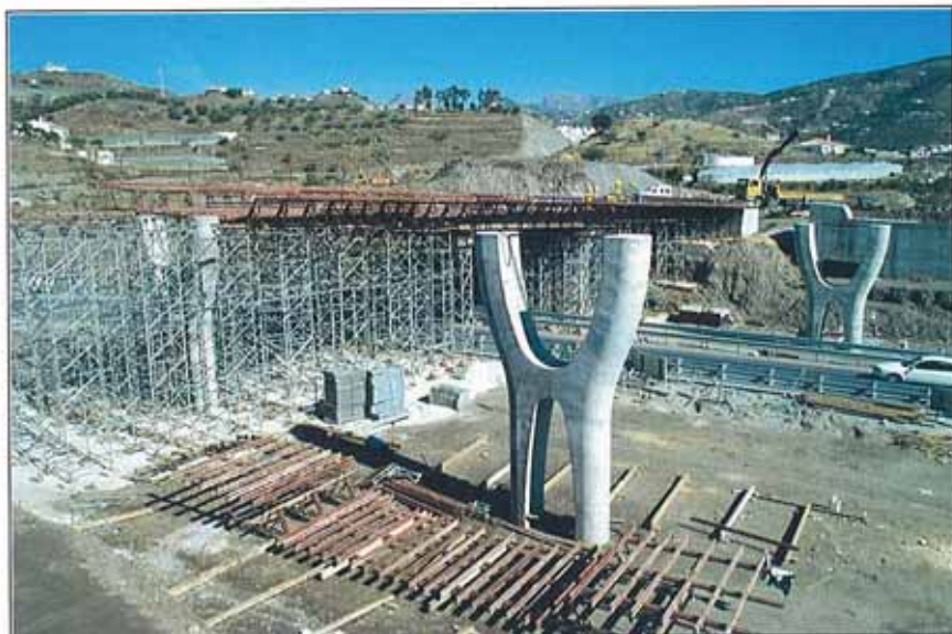
Detalle del proceso de construcción del enlace de Torrox.
