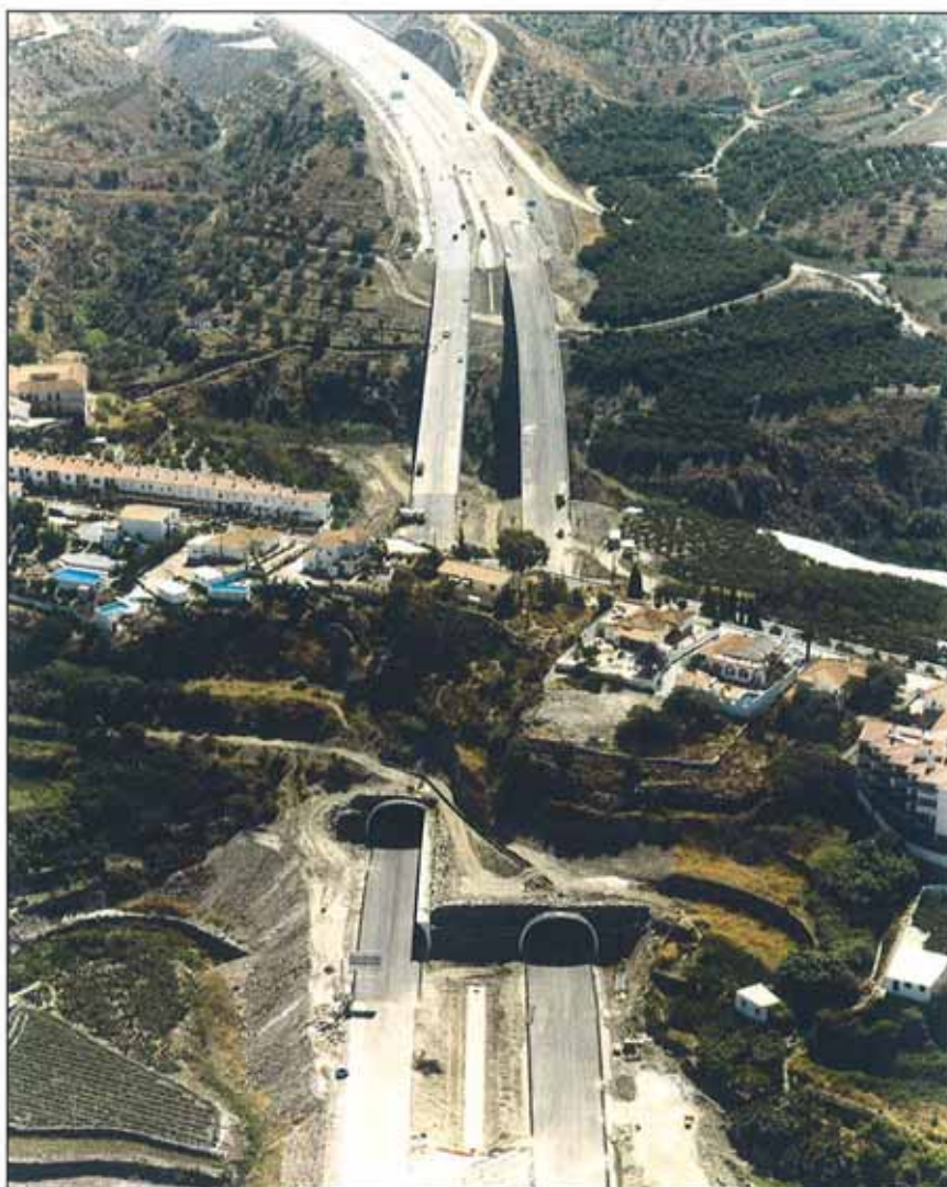
Túnel de Torrox en el p.k. 108+600. La calzada izquierda tiene una longitud de 120 m, y la derecha de 150 m.
