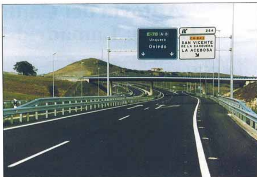
La sección transversal de la autovía se compone de dos calzadas de 7 m cada una, con arcenes interiores de 1 m y exteriores de 2,5 m, y mediana de 11 m.
