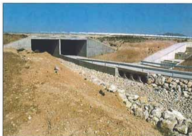
Dos muestras de la permeabilidad transversal de la autovía, así como de las importantes obras de drenaje. A la izquierda, estructura E-9.4, Camino del Monte y El Ramblón.
