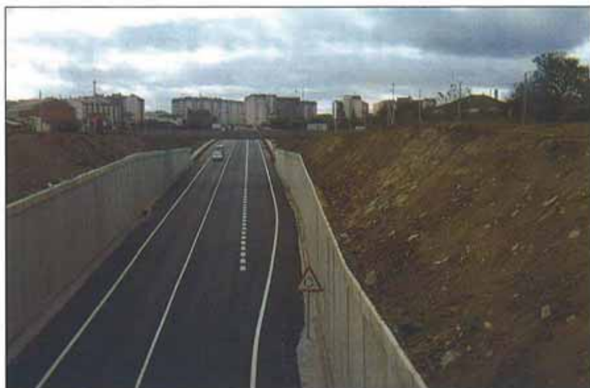
La obra cuenta con tres pasos superiores, además de una pasarela peatonal.
