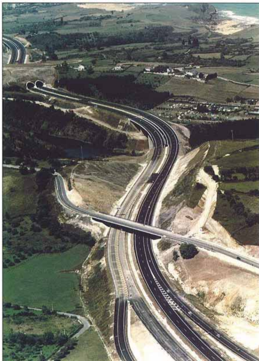
Vista general p.k. 5 000 al 7 000 (estructuras E-8 y falso túnel Arenal de Morís).
