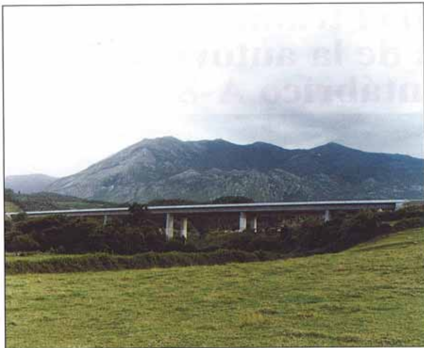
Viaducto del Espasa, de 244 m de longitud y altura máxima de pilas de 23 m.
