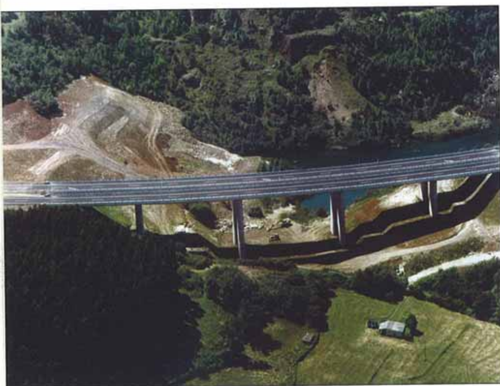
Viaducto de San Lino, de 206 m de longitud, y 31 m de altura máxima de pilas.
