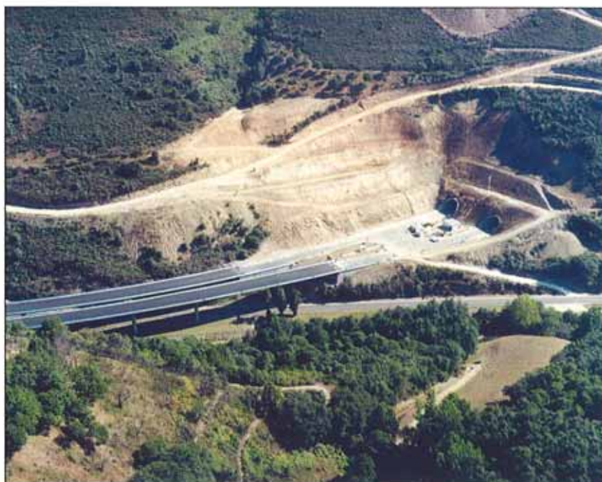
Boca oeste del túnel de Trabadelo.
