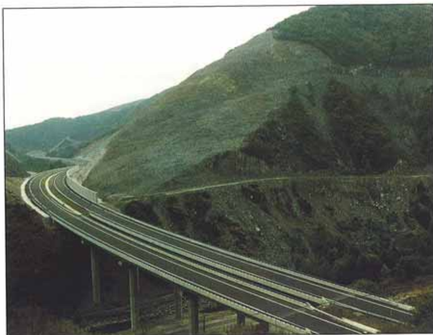
Cañón del río Valcarlos. Viaducto de Cachibobos.
