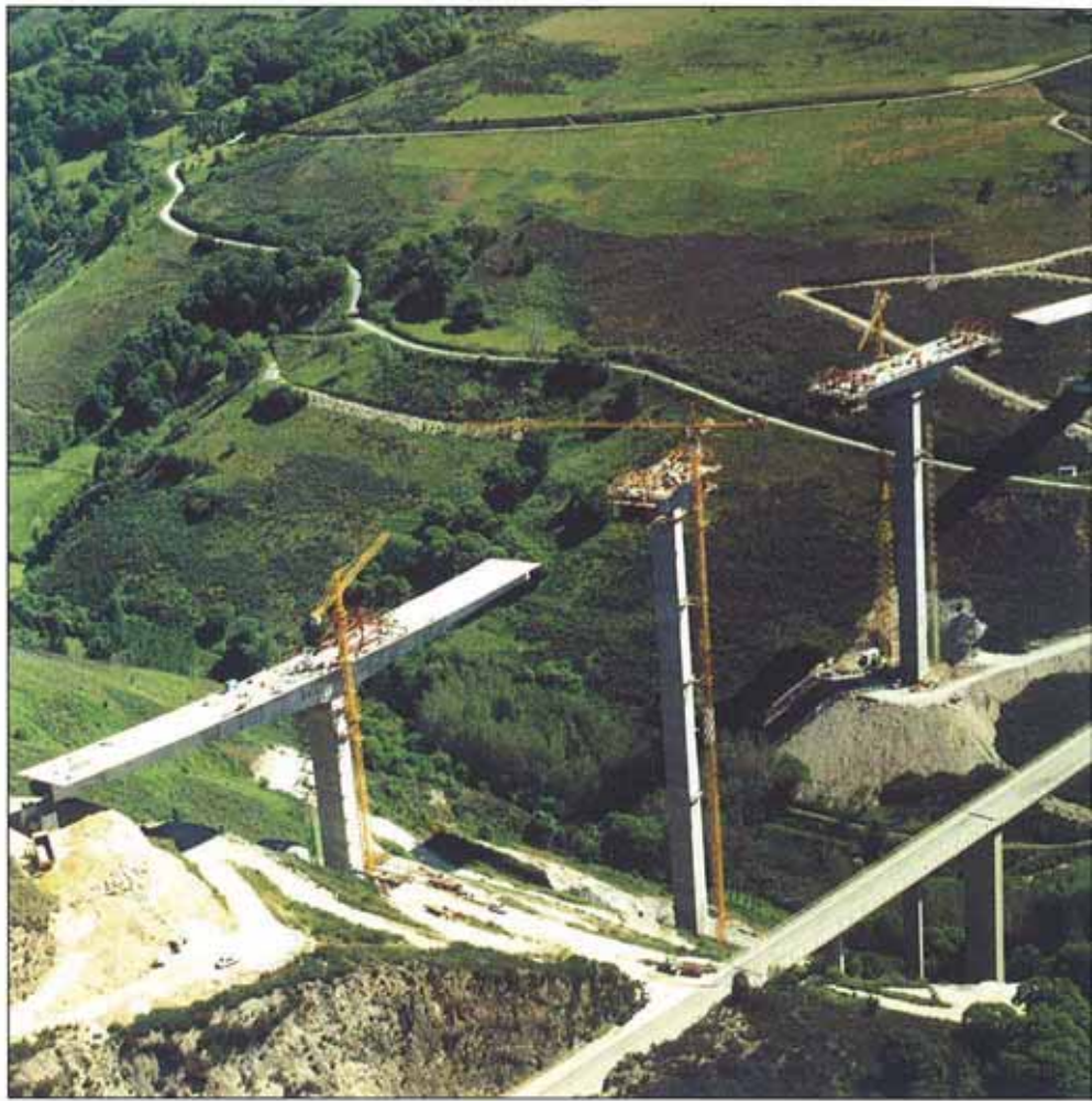
Viaductos de Samprón y Ruitelán en fase de construcción.
