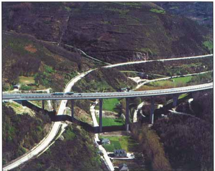
Viaducto de Vega de Valcarce.
