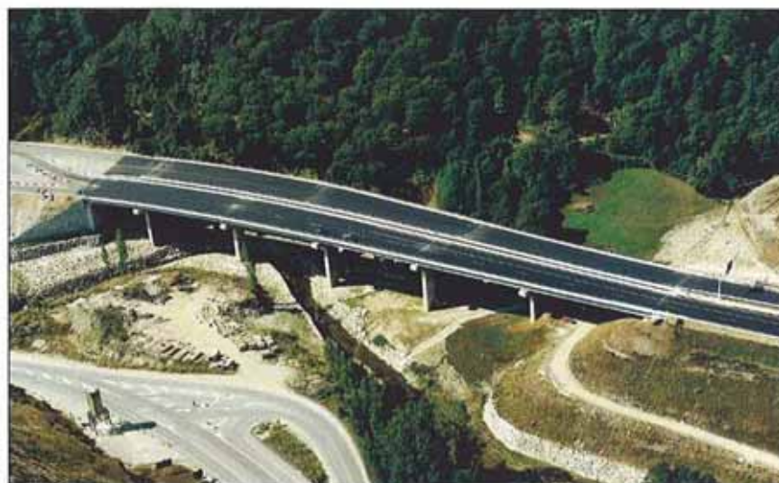
Viaducto de Ambasmestas.
