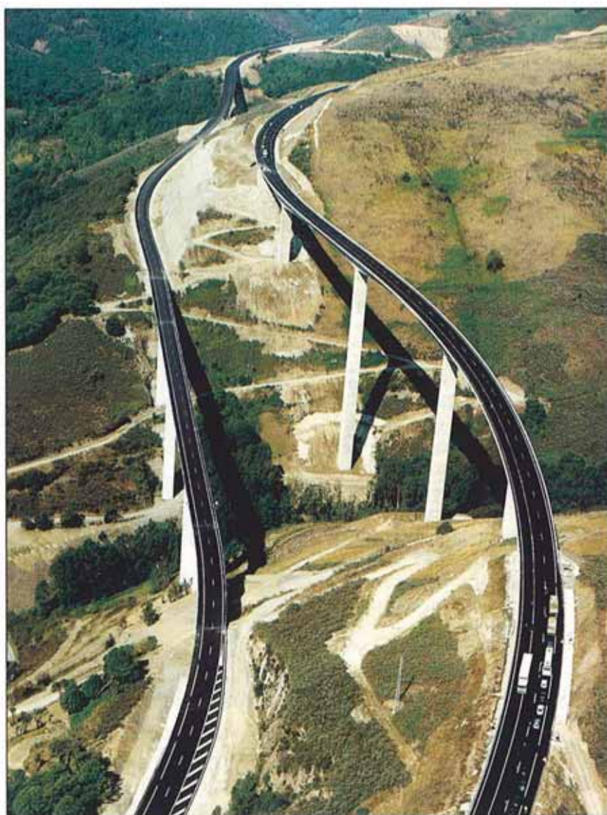
Viaductos de Samprón y Ruitelán.
