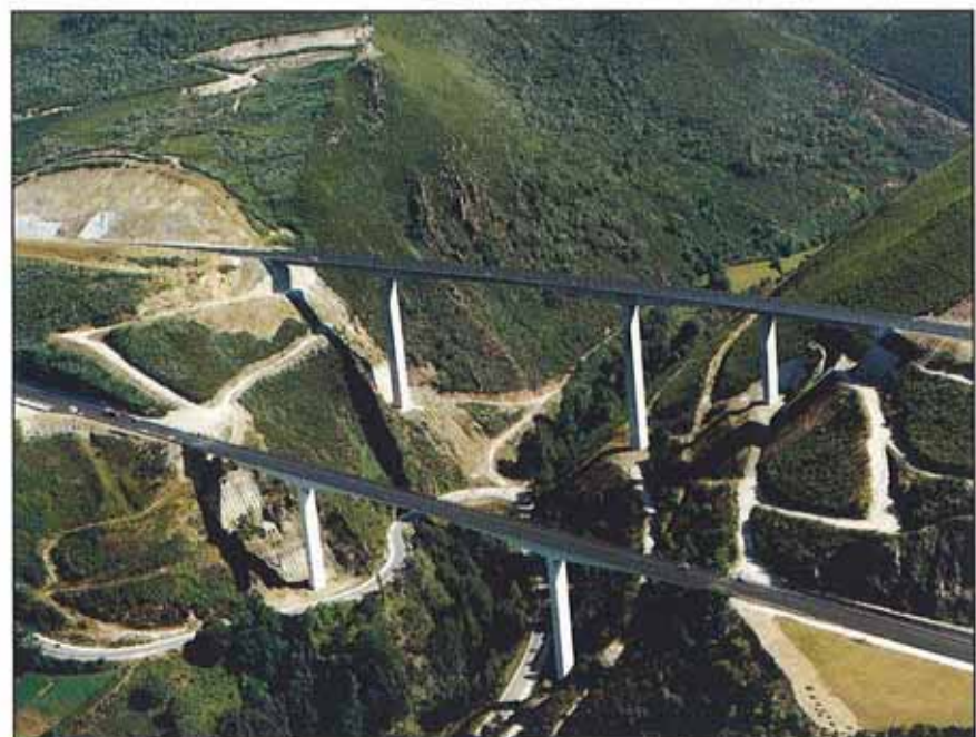
Viaductos de Las Lamas.
