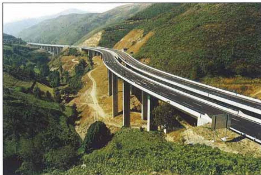
Vista general de los viaductos de Castro y sobre el río Lamas.
