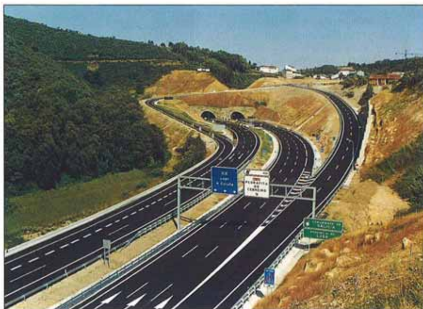
Túnel de Piedrafita y semienlace sur. Boca desde la provincia de León.
