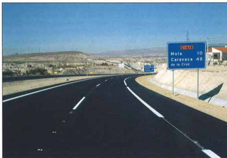
Para el drenaje longitudinal se han realizado 165 000 m de cuneta revestida de hormigón.
