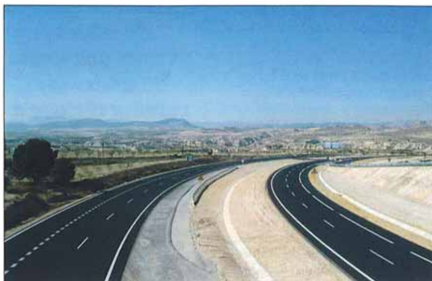
Para la construcción de este pavimento se han empleado 740 000 t de mezclas bituminosas, en su mayor parte fabricadas en una planta de producción especialmente instalada para la obra.
