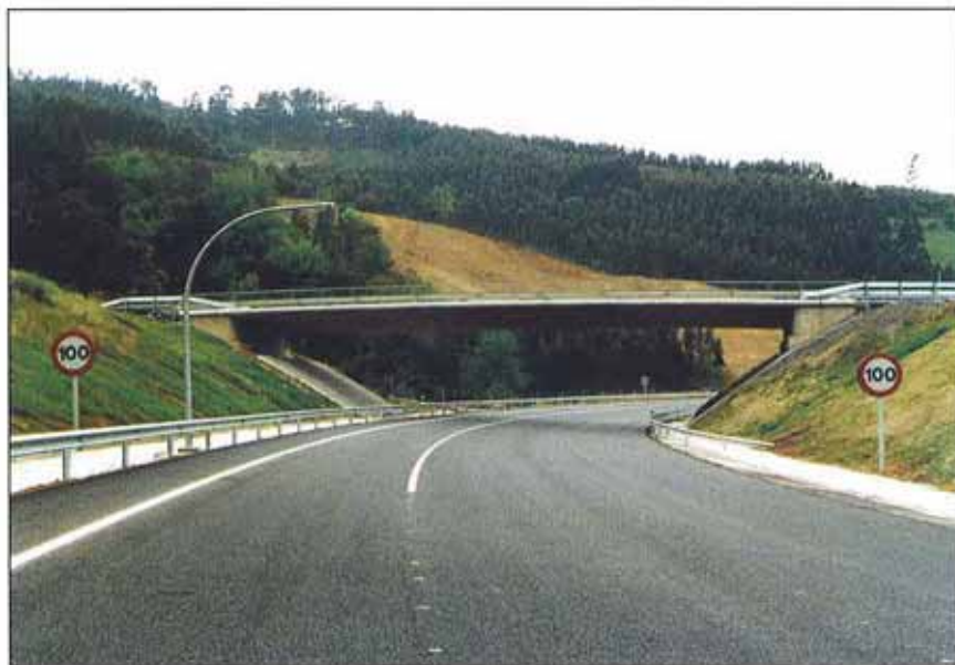
La sección tipo adoptada está constituida por dos carriles de 3,5 m, arcenes de 1,5 m y bermas de 0,5 m.
