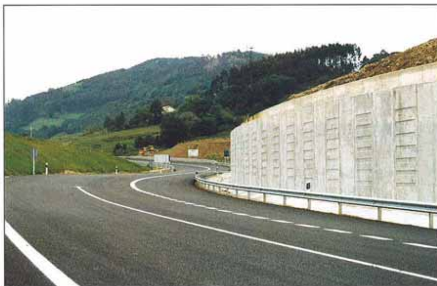
El tramo tiene una longitud de 13,4 km, de los que 11,8 son de vía rápida.
