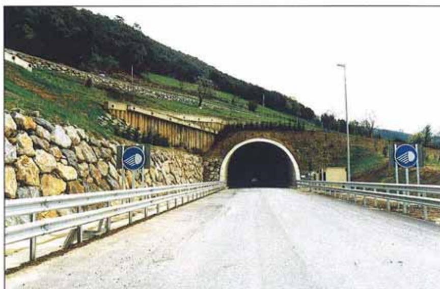
La peculiar orografía del terreno ha obligado a la construcción de túneles, como el de Limpías y el falso túnel de Cereceda.
