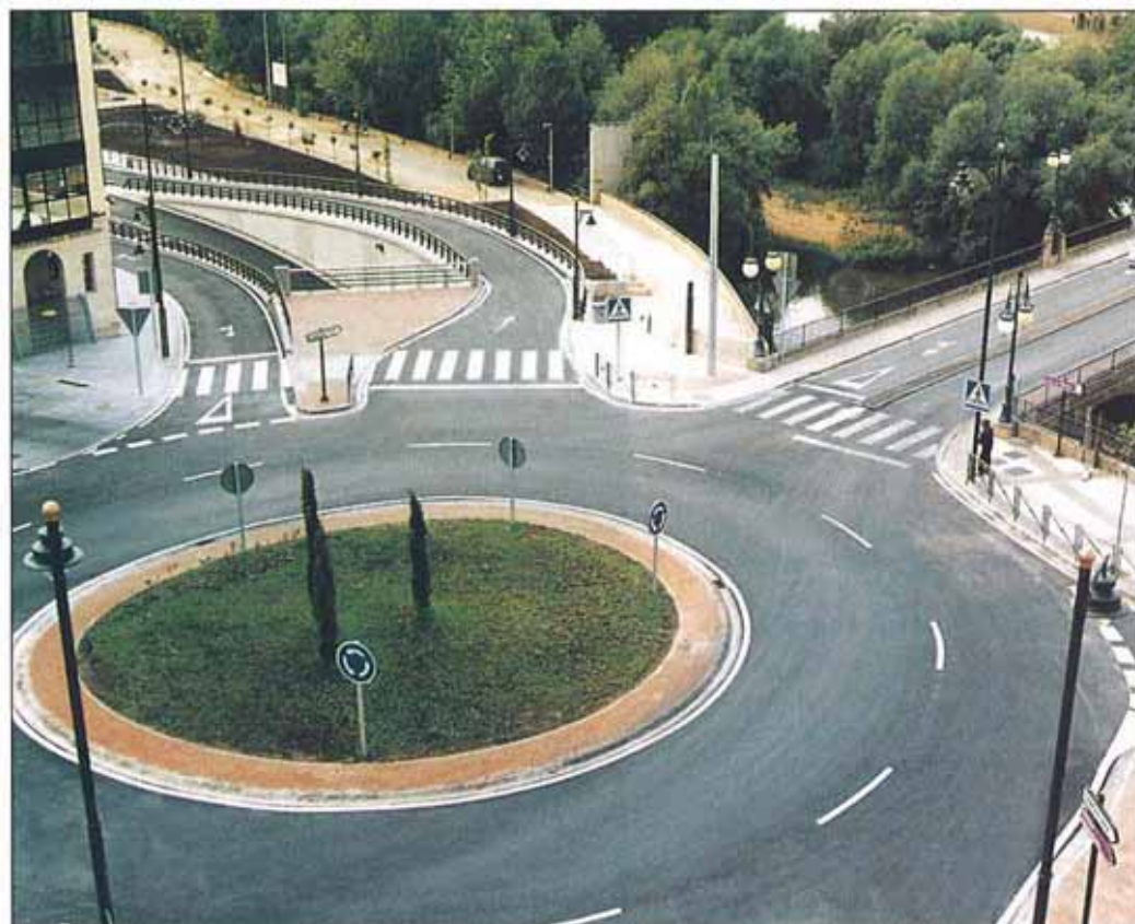
La obra ha supuesto una inversión de casi 448 Mpta.
