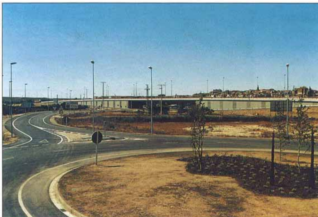
El paso elevado permite eliminar intersecciones que habían alcanzado un numeroso tráfico pesado entre la carretera, la ciudad y el polígono industrial.
