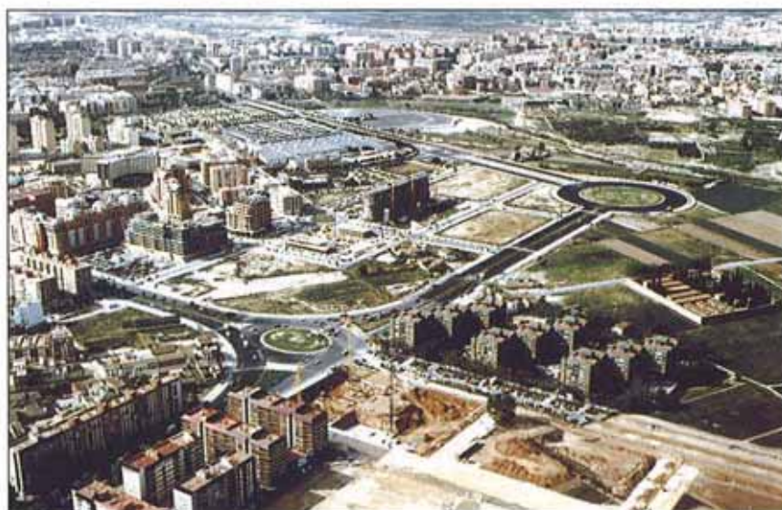
Vista general del tramo 9.
