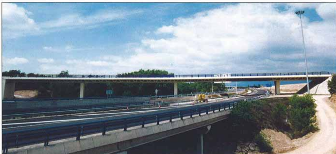
Vista general de la obra.
