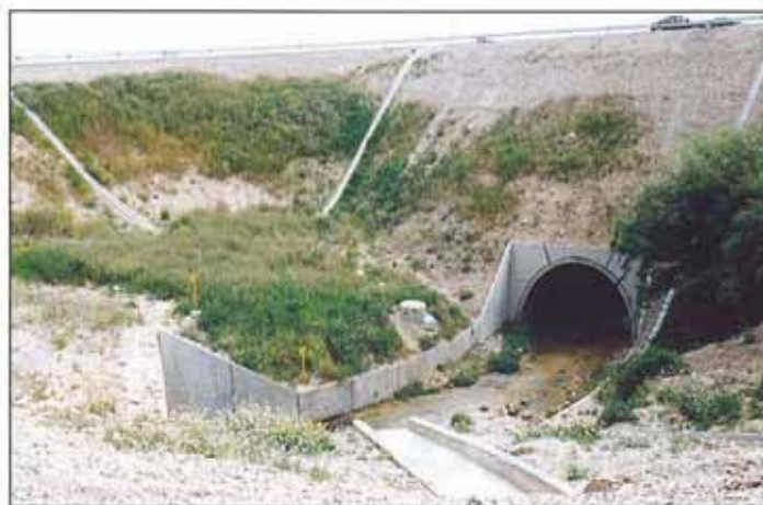
Obra de drenaje y paso de fauna.
