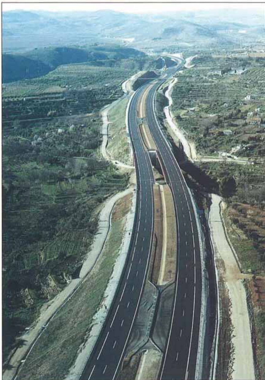
Vista aérea de la zona del viaducto de la Cañada de Pomma.
