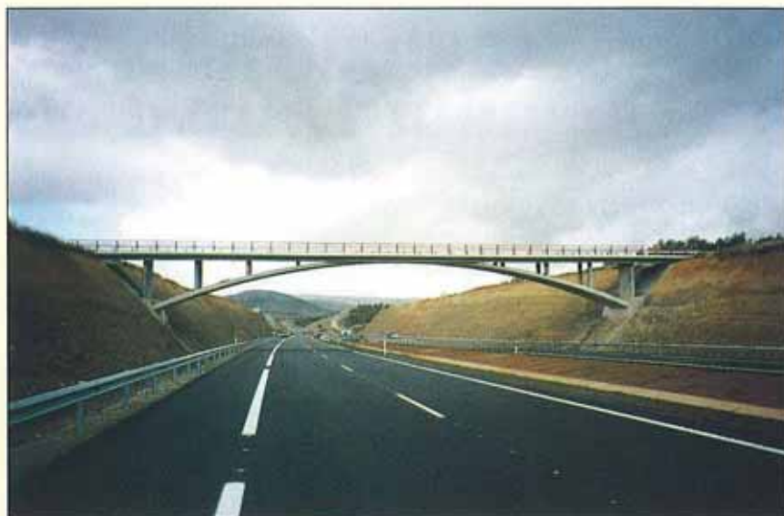
El tramo Alhendín - Dúrcal cuenta con 5 pasos sobre la autovía.
