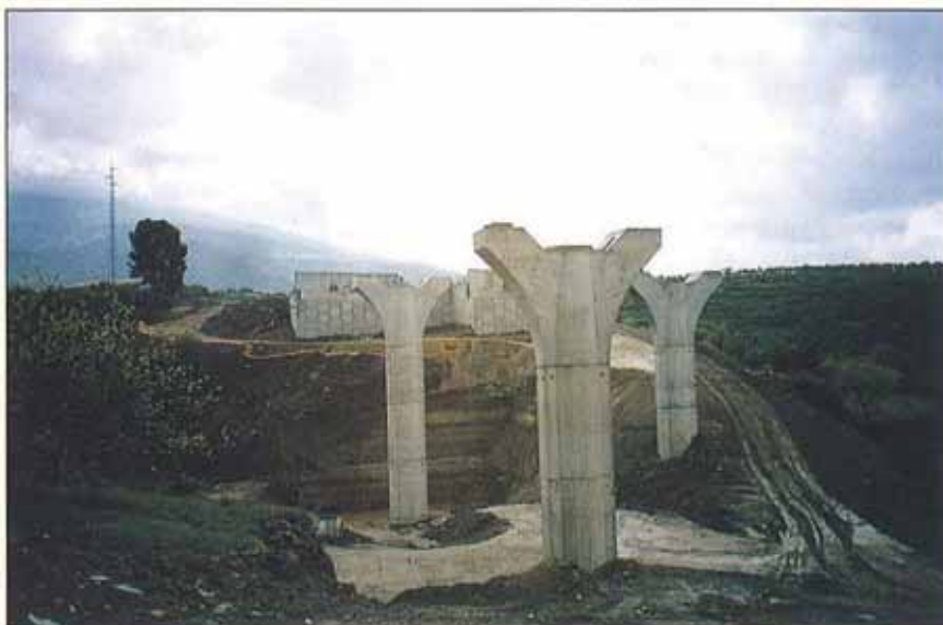
Pilas y muros de estribos del viaducto de la Cañada de Pomma durante su construcción.
