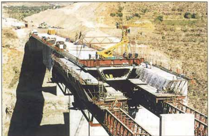
Detalle de la construcción del tablero del viaducto sobre el río Dúrcal, con cimbra autoportante.
