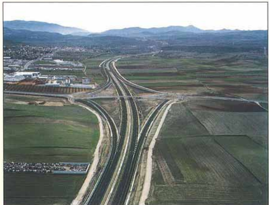
Enlace de Padul. En la fotografía se puede apreciar el trazado de la carretera en sentido a Motril.
