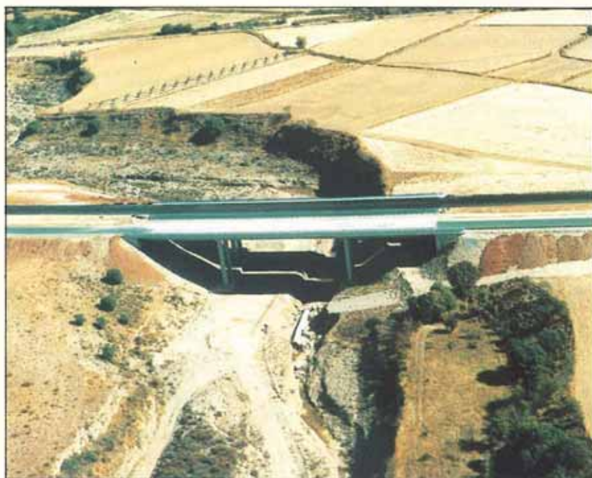
Viaducto sobre el río Isuela.
