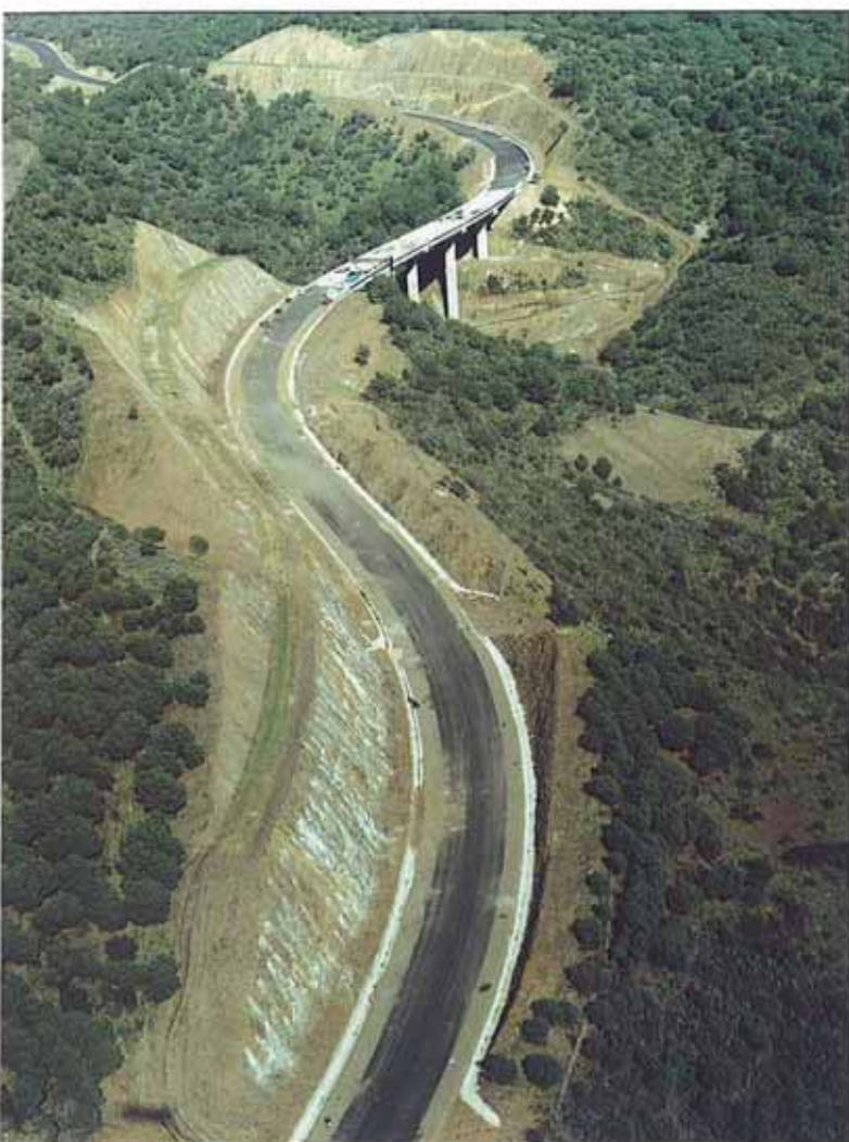
Viaducto en el DO 14+200.
