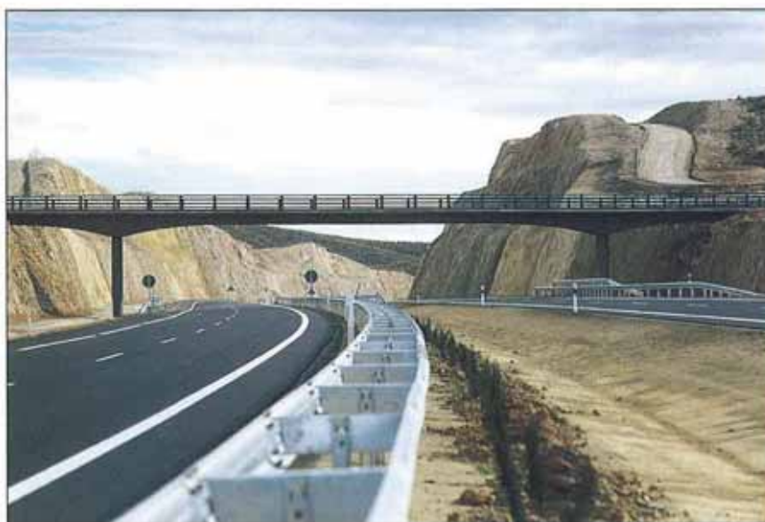
En total, se han construido 25,6 km de tronco de autovía.
