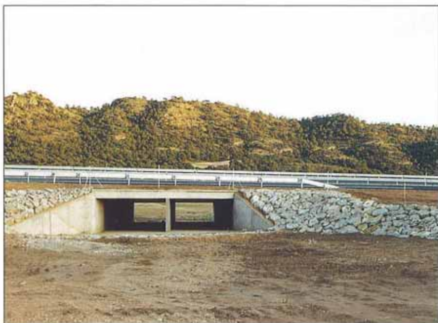
Obra de drenaje transversal.
