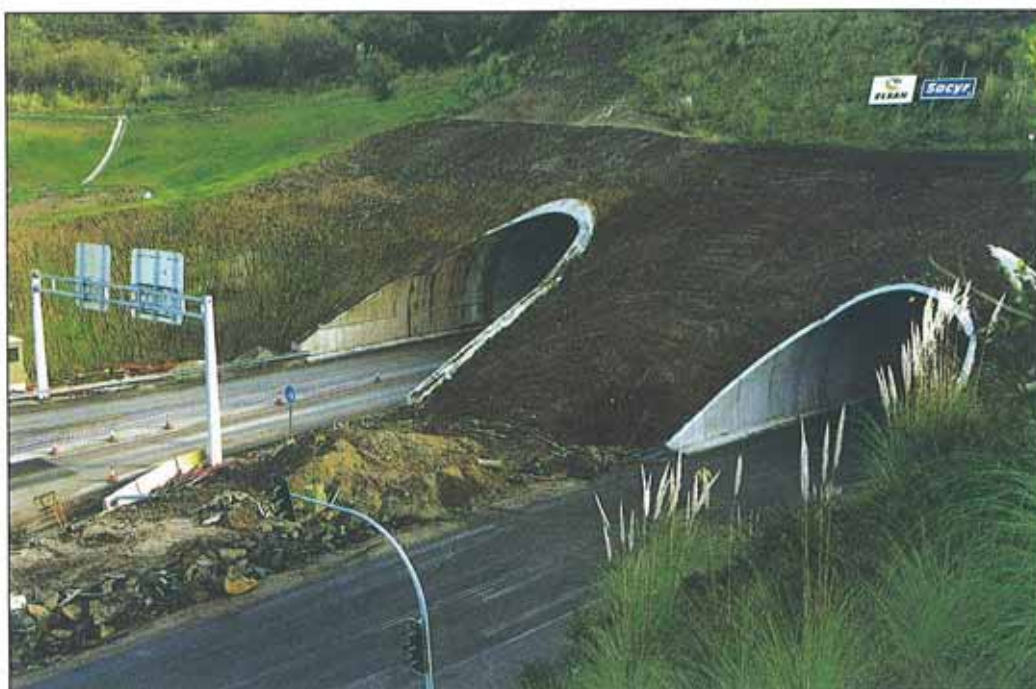
Túneles paralelos de 614 m de longitud.
