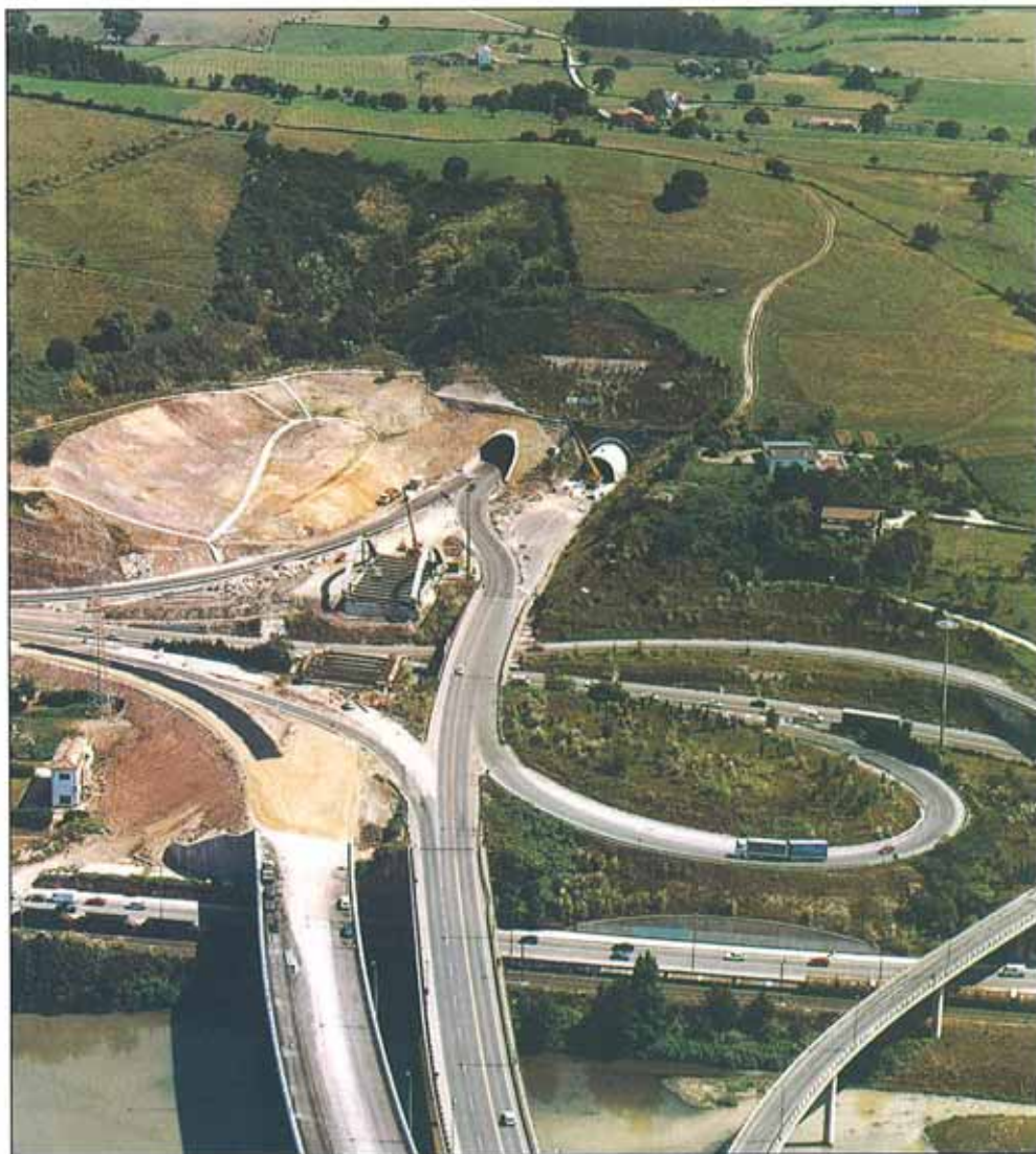
Las bocas de los túneles en plena construcción.
