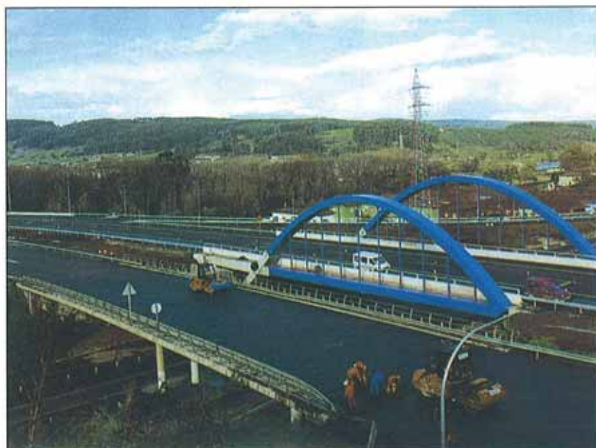
Uno de los viaductos de la obra.
