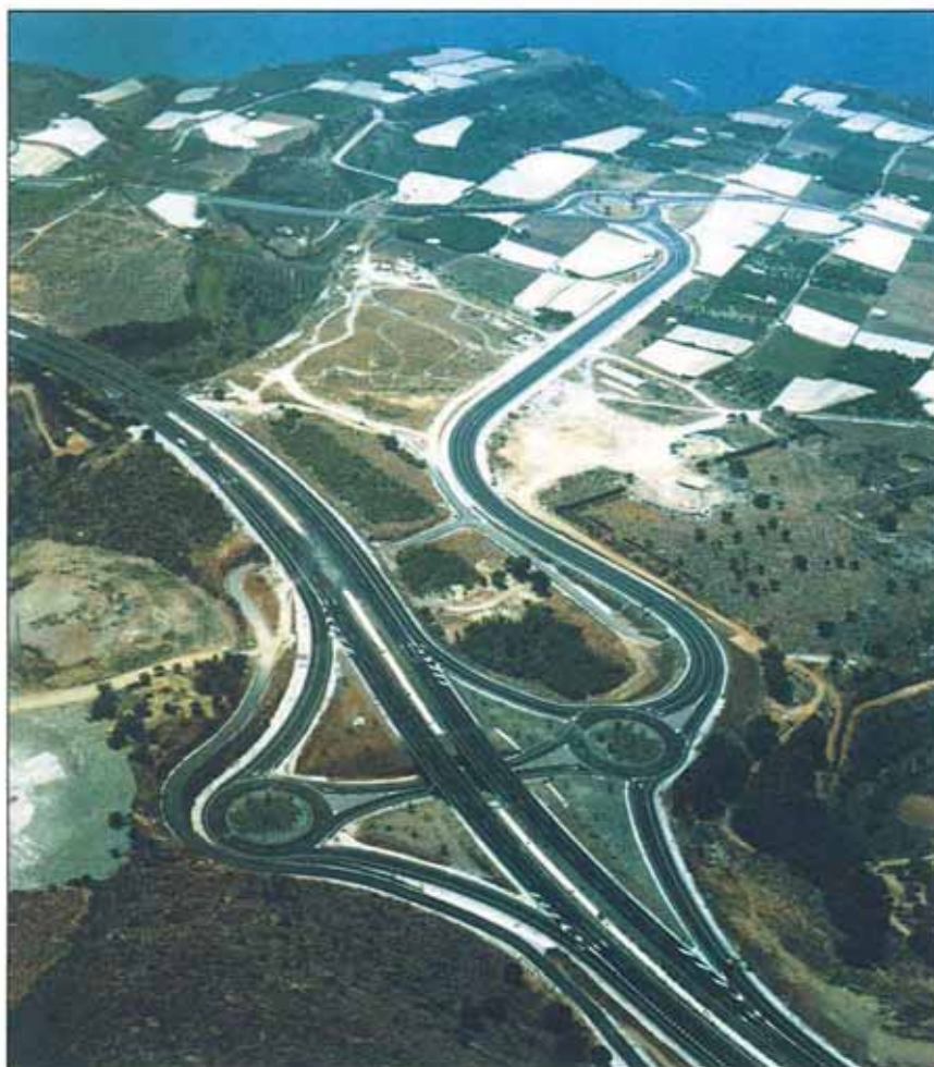
A lo largo de la obra se han dispuesto dos enlaces.
