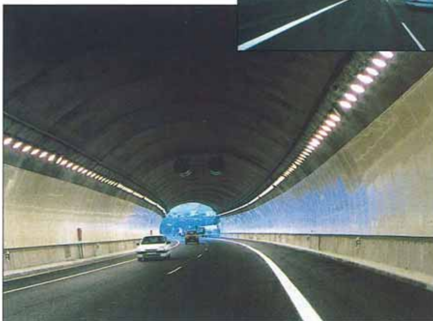
Interior de los túneles del Capistrano.
