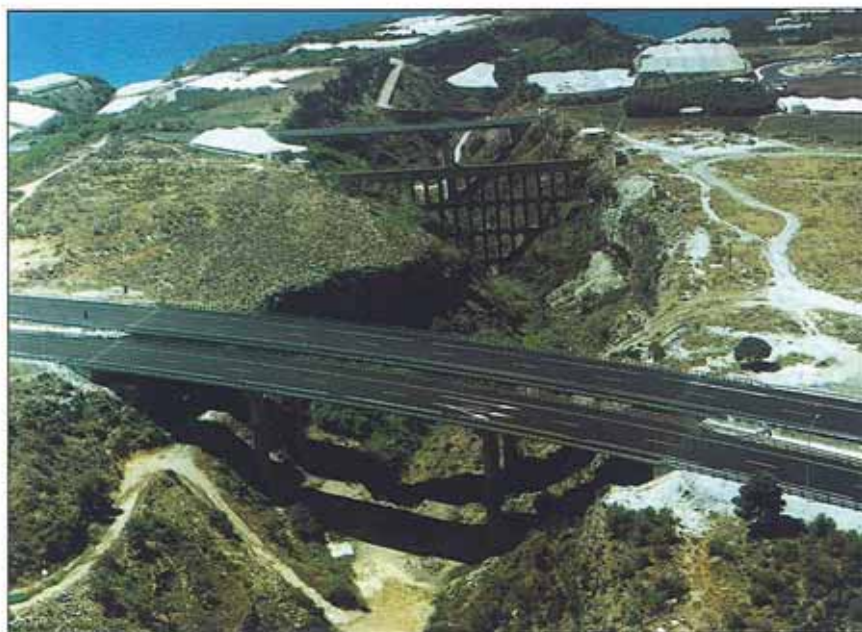
En el tramo se han construido 7 estructuras.
