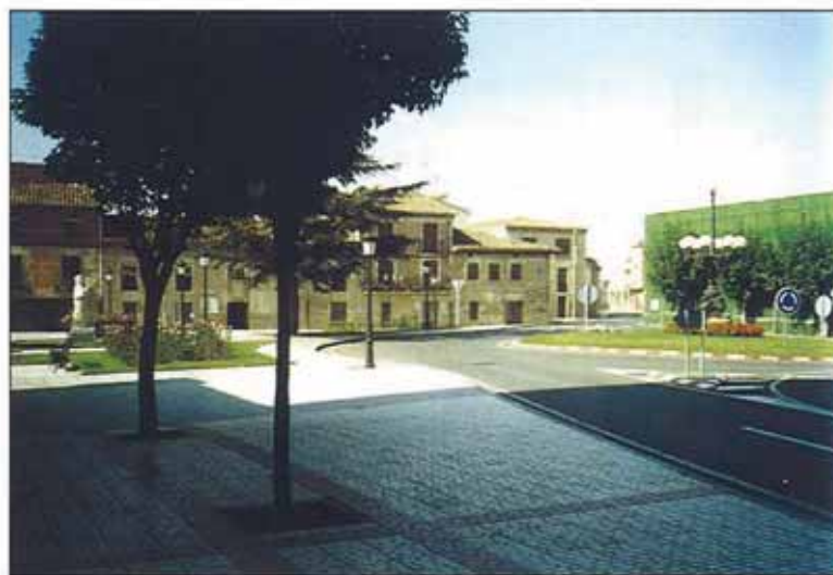
La zona de actuación de la travesía de Santo Domingo de la Calzada tiene una longitud de 1 720 m, y su trazado en planta y alzado se mantiene igual al anterior.
