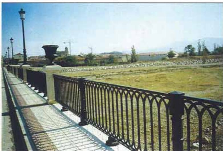
Vista parcial del puente sobre el río Oja, en el que se han realizado diversas obras de reparación y acondicionamiento.
