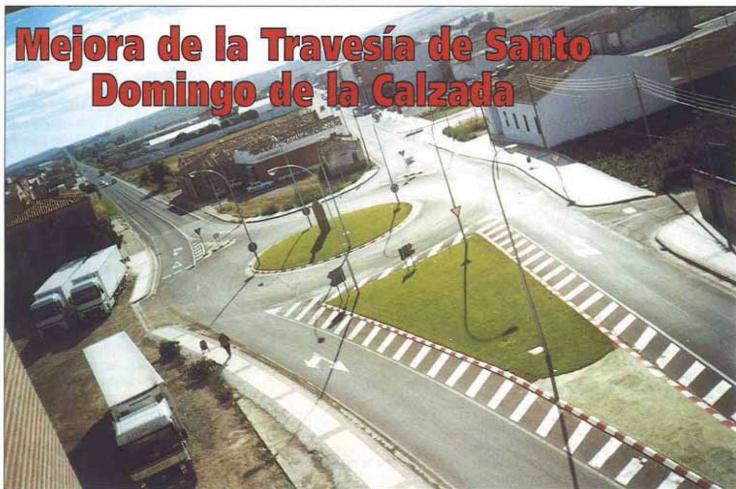
Vista panorámica de la travesía. En el centro, una de las dos nuevas glorietas construidas.
