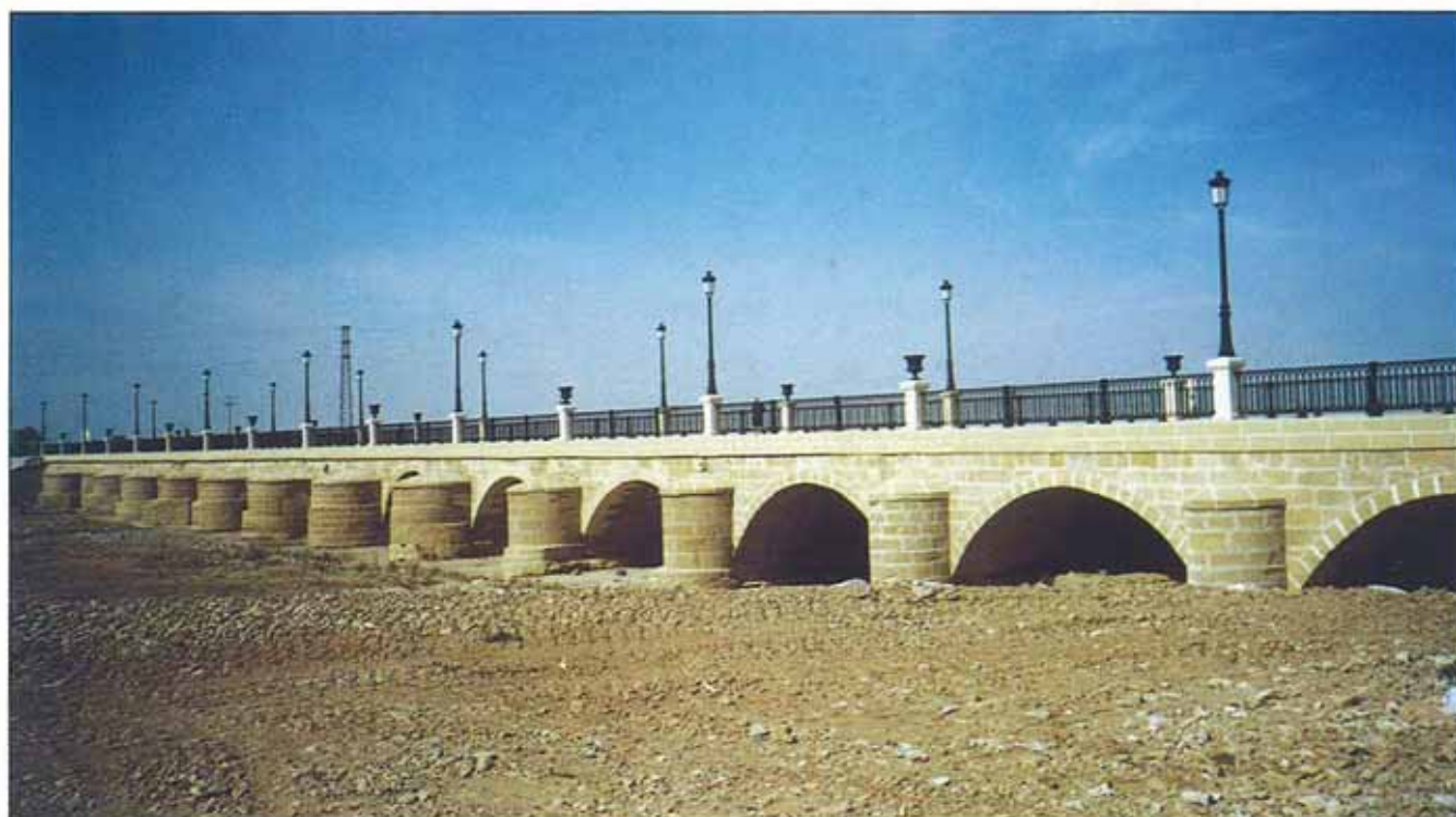
En el puente sobre el río Oja se han instalado 18 farolas de fundición de 2,70 m de altura sobre pilastras de hormigón prefabricado de 0,80 m de altura, semejantes a las instaladas en la barandilla de hormigón de la Avda. Juan Carlos I.
