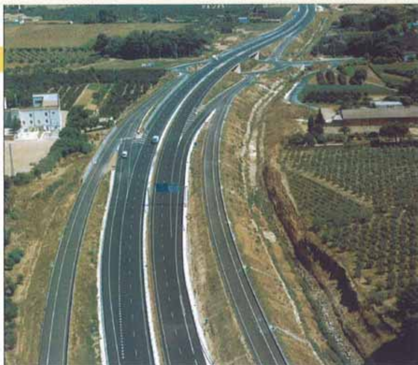
La obra ha supuesto una inversión de 5 195 Mpta.
