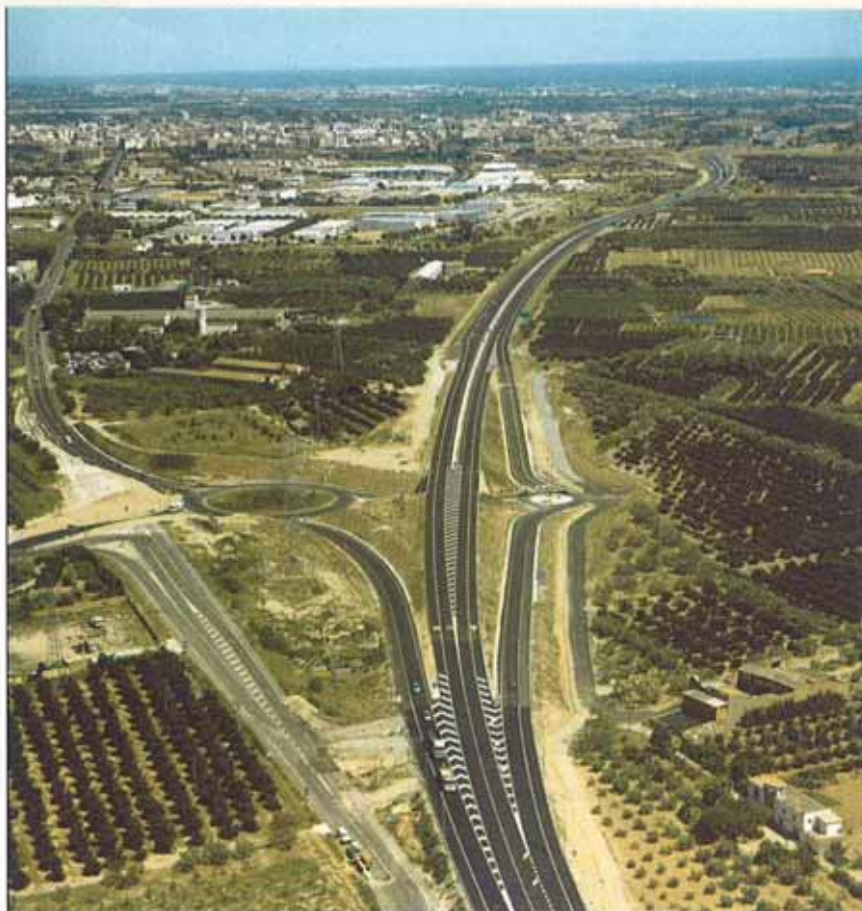
Enlace de Falset, compuesto por dos glorietas y un paso inferior con una estructura de vigas de hormigón.
