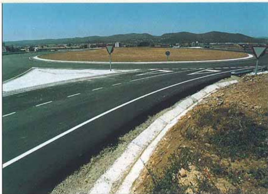
En la foto, una de las rotondas ejecutadas a lo largo de la obra.
